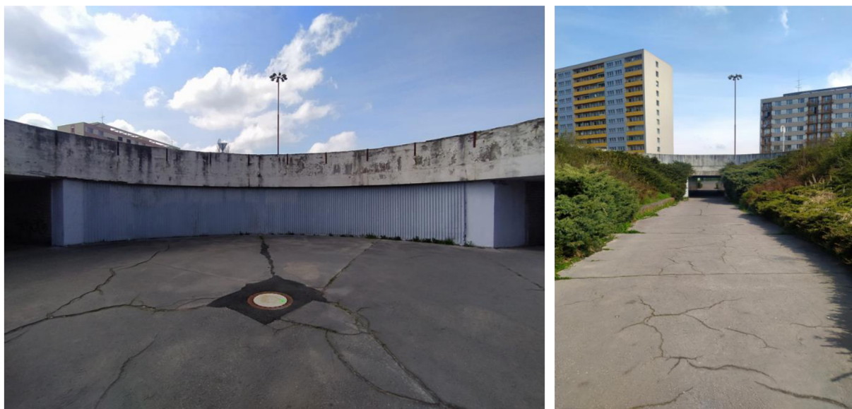
17. Pohled do čela kineatru a na týlní vstup. Zdroj: archiv autora
