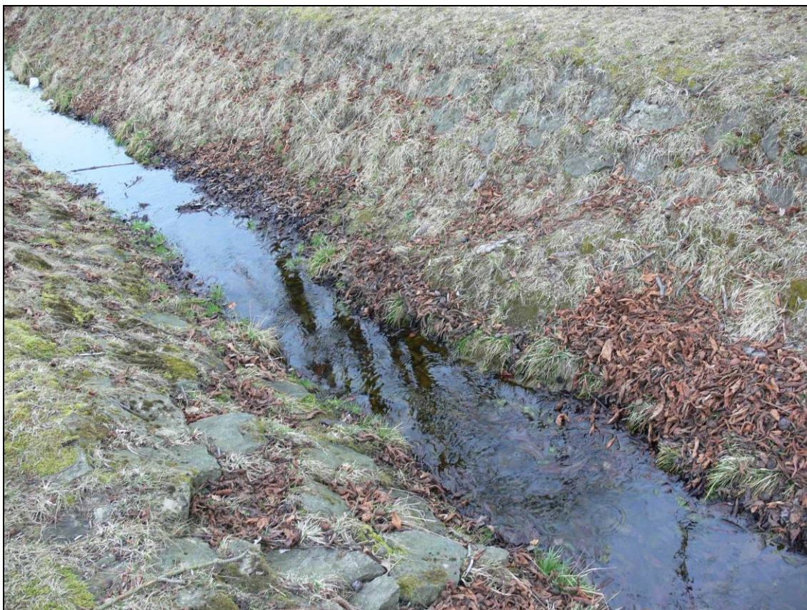
Obr. č. 8 Opevněné koryto Budňanského potoka. (Foto D. Kincl)
