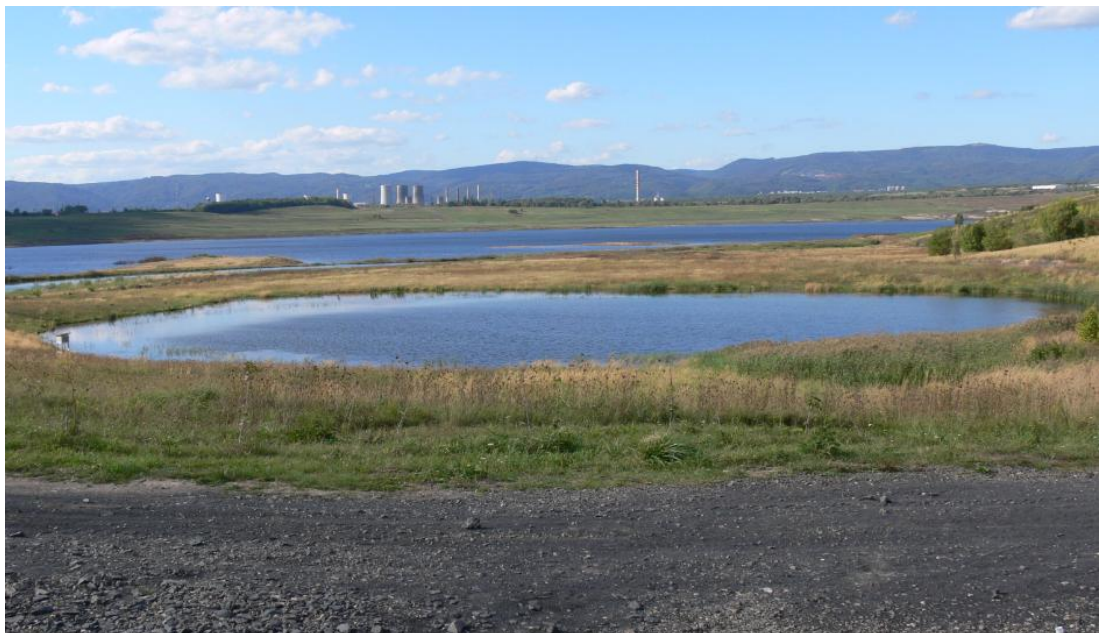
Fotografie 3: pohled z jihozápadního vršku dále západním směrem na Střimickou výsypku, kde pod výsypkou vzniká jezero Most; foto: Rain, 2011
