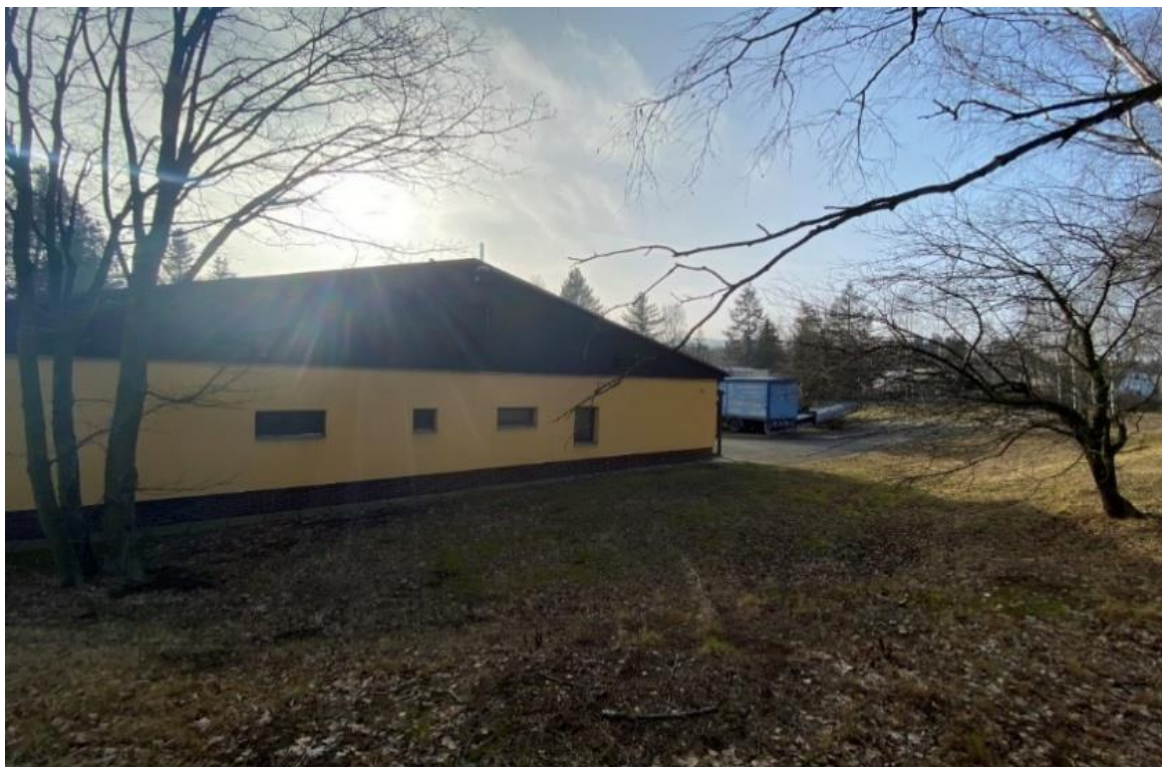
Obrázek 5 - Hlavní budova čistíren odpadních vod Kovohutí (Doubravová J., 2019)
