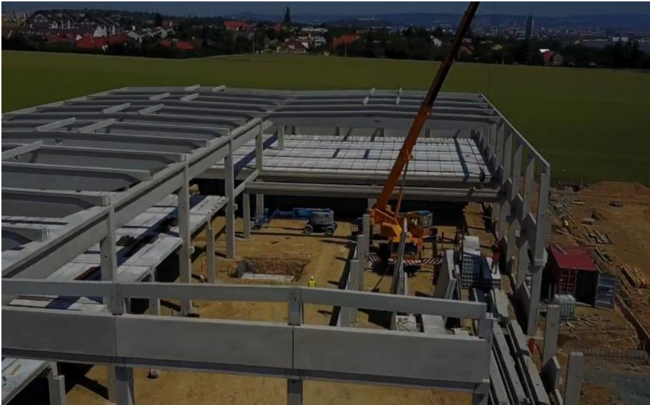
Obr. 9-6 – montáž strešných väzníkov [60]
