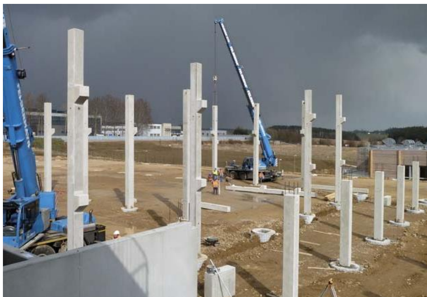
Obr. 9-1 – osadenie stĺpov do kalichov [56]
