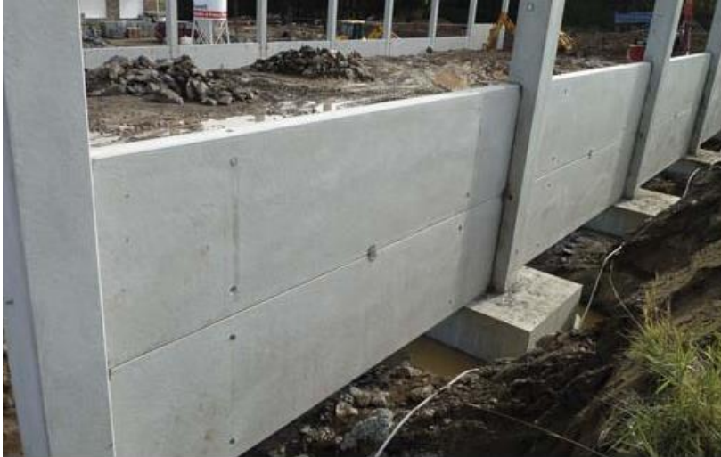
Obr. 9-2 – osadenie základových panelov [57]
