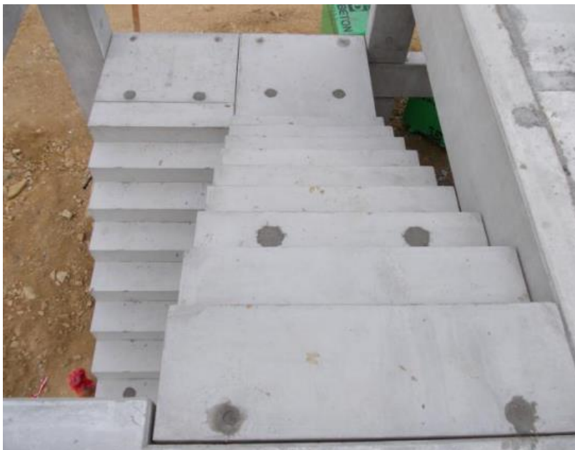
Obr. 9-4 – montáž schodišťových ramien [59]
