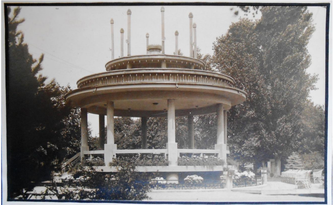
8. Hranice na Moravě, hudební pavilon, fotografie realizace, 1930. Foto: archiv MUO
