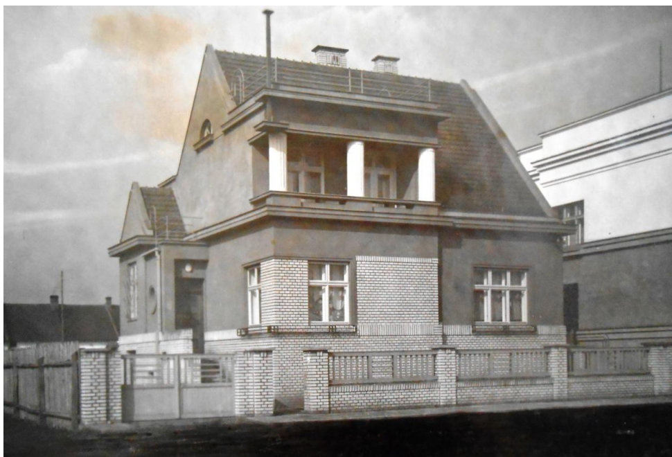
2. Kojetín, rodinný dům J. Černé, pohled na fasádu, 1927. Foto: archiv MUO
