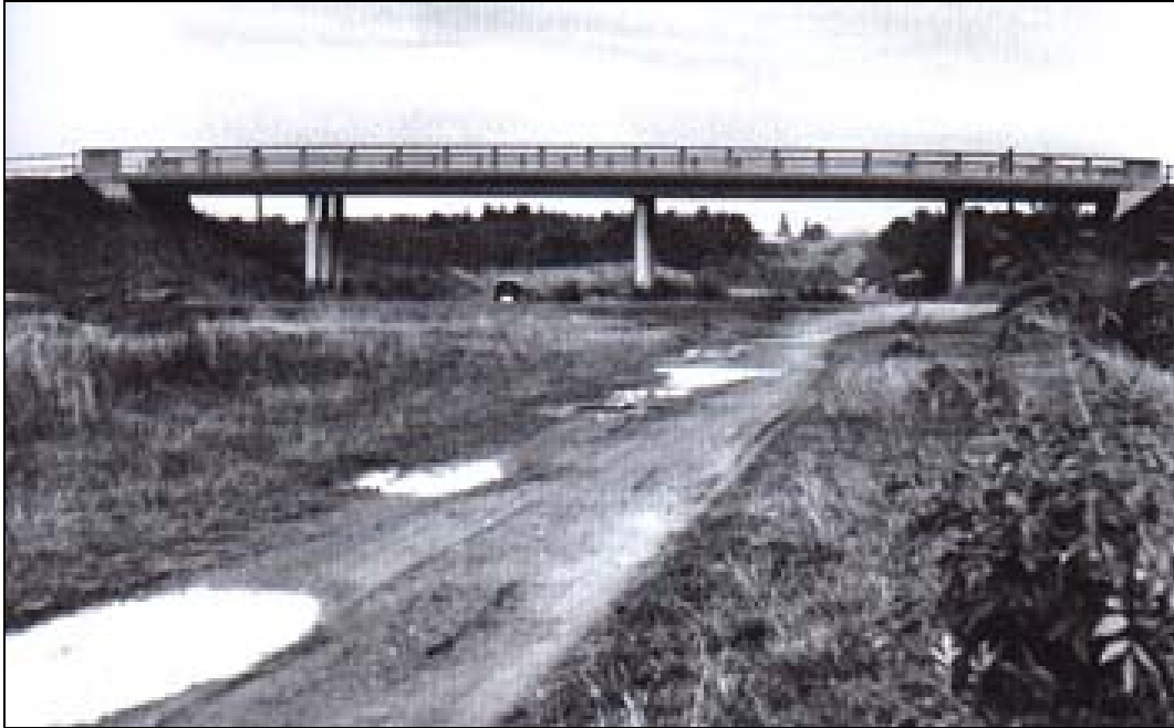
Obr. 2.1 Úsek nedokončené dálnice před Průhonicemi za Prahou v šedesátých letech [1]
