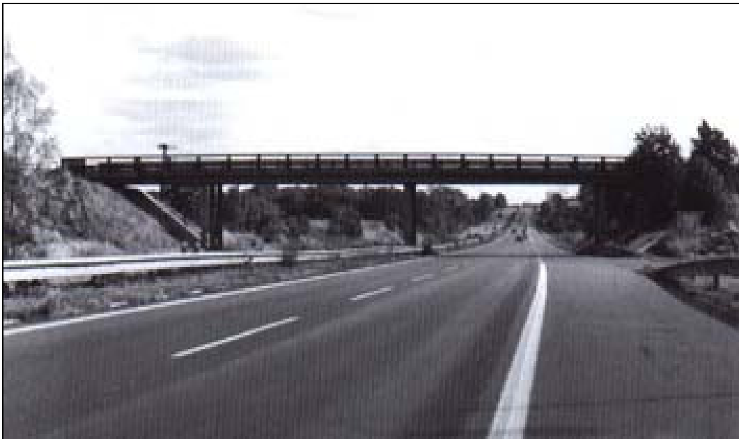
Obr. 2.2 Stejně místo v osmdesátých letech (dálnice D1) [1]
