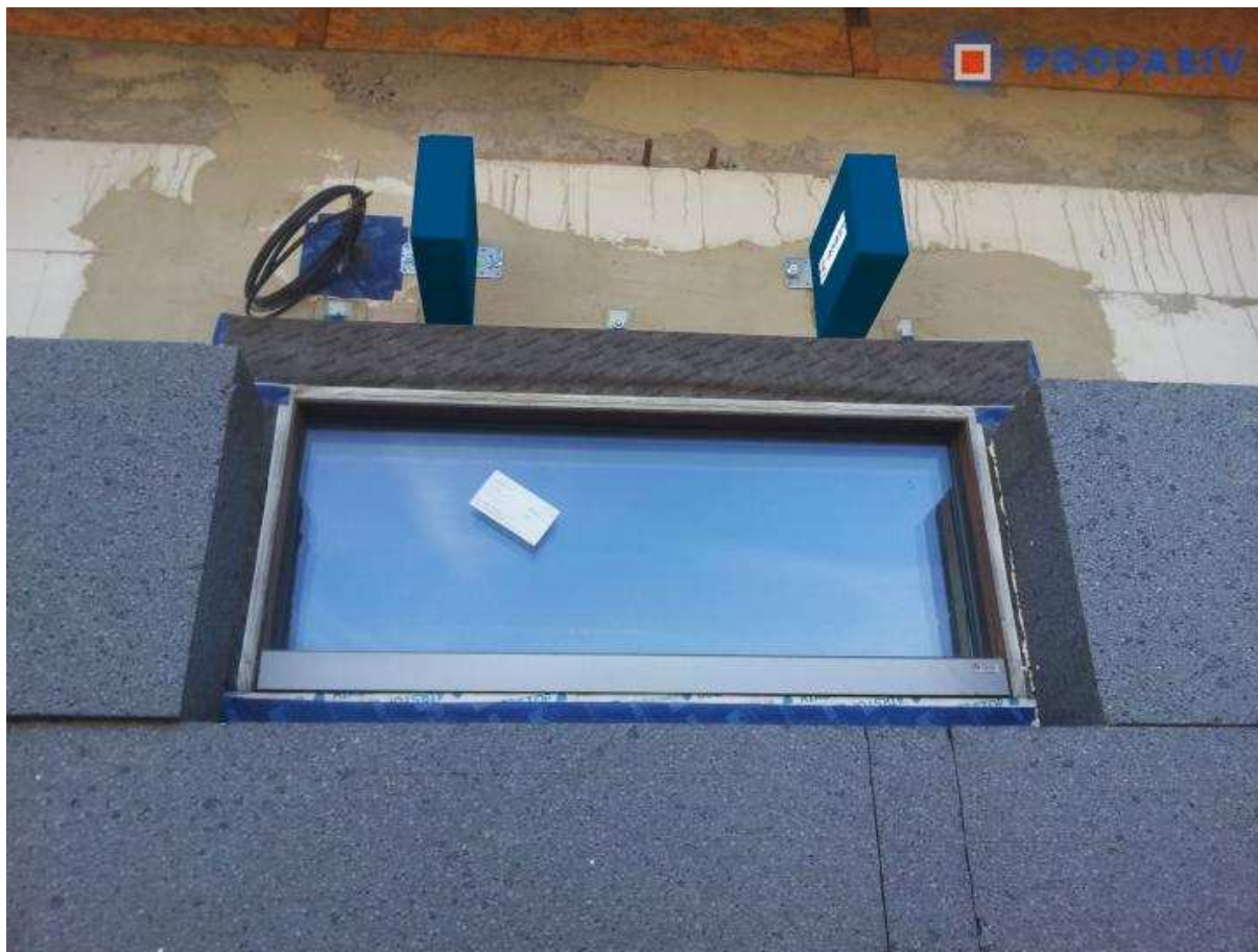
Obr. 16: Ukázka z realizace firmy PROPASIV, detail izolace nadpraží okna. (Propasiv CZ, © 2017)
