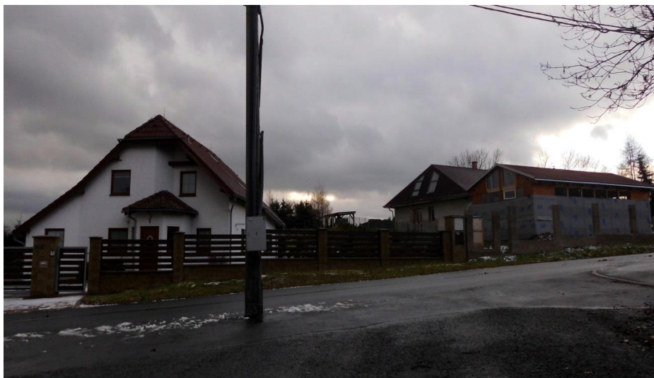
Příloha č. 13: Neodkanalizovaná část ul. Dvojhradí (foto: Vlastní 11/2013).
