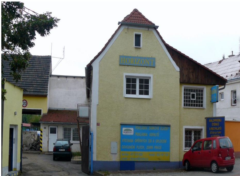
Příloha č. 6: Areál firmy Horizont - ul. Školní (foto: Vlastní 10/2013).
