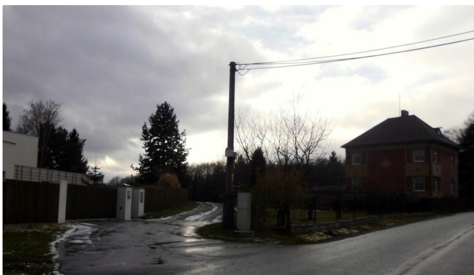
Příloha č. 14: Neodkanalizovaná část ul. Dvojhradí (foto: Vlastní 11/2013).
