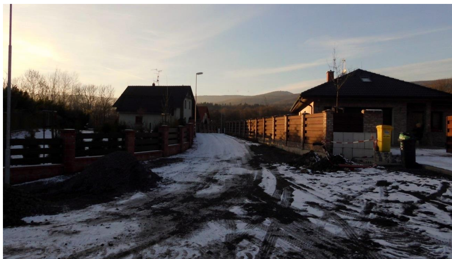
Příloha č. 15: Neodkanalizovaná část ul. Pod Lesem (foto: Vlastní 11/2013).
