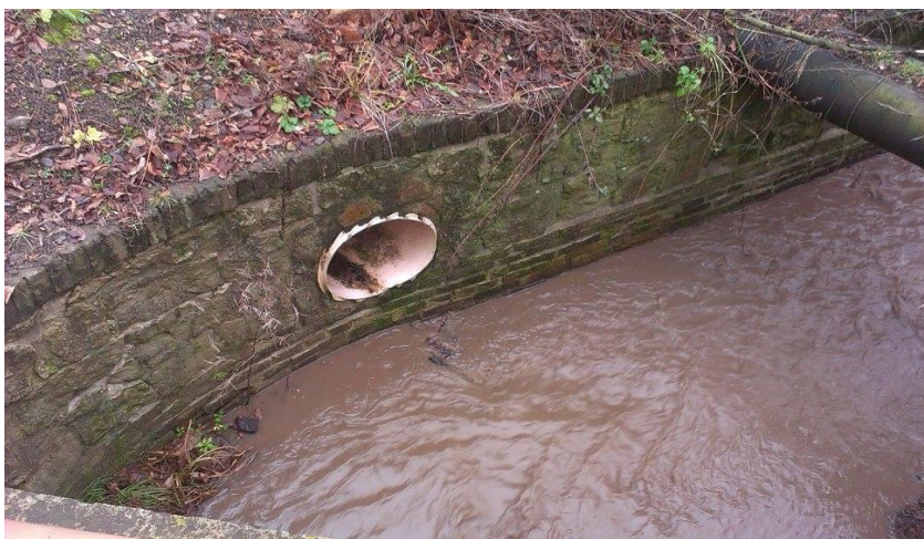
Obázek č. 9: Náměstí Svobody - vyústění do potoka (foto: Vlastní 12/2013).
