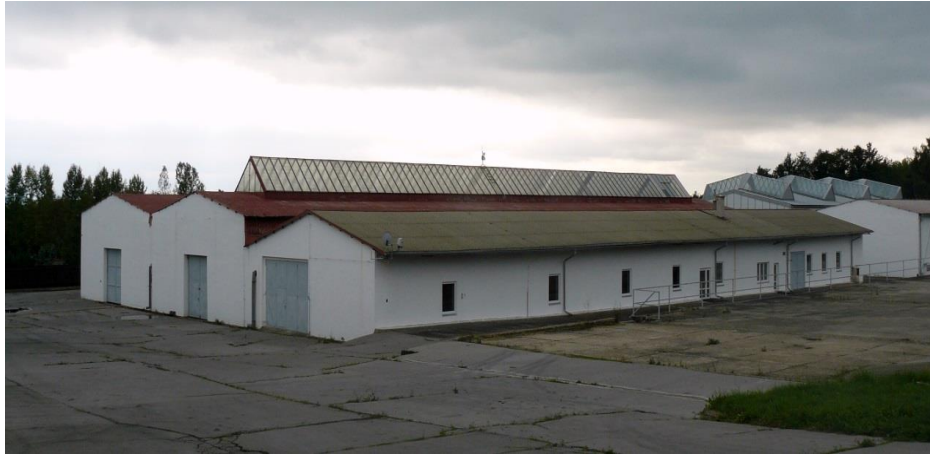
Příloha č. 3: Areál firmy MARTEX NORD s.r.o. - ul. Školní (foto: Vlastní 10/2013).
