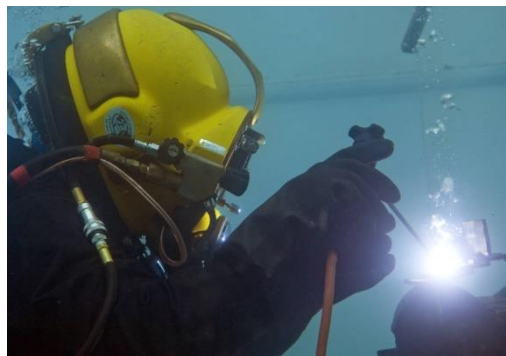
Obr. 3 Svařování pod vodou [20]
