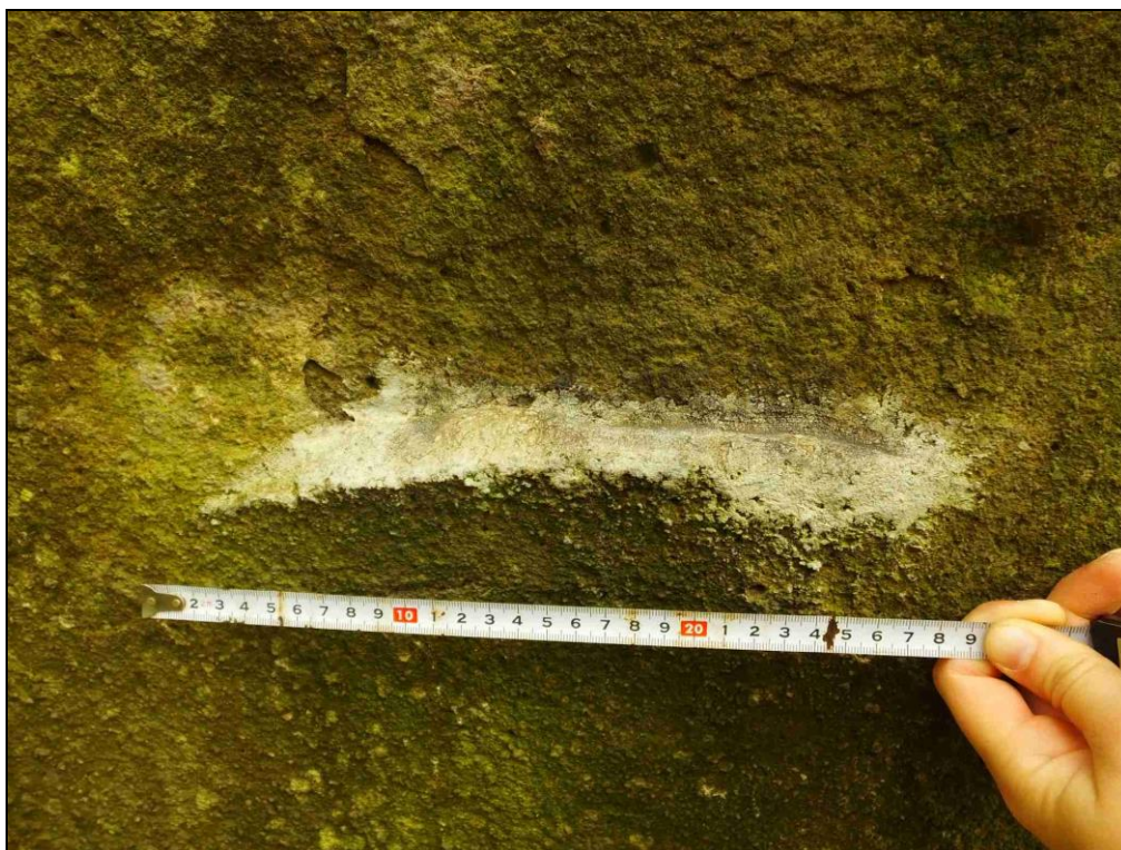
Obr. 33: Chyt zpevněný síkováním. (Vaculová 2016)
