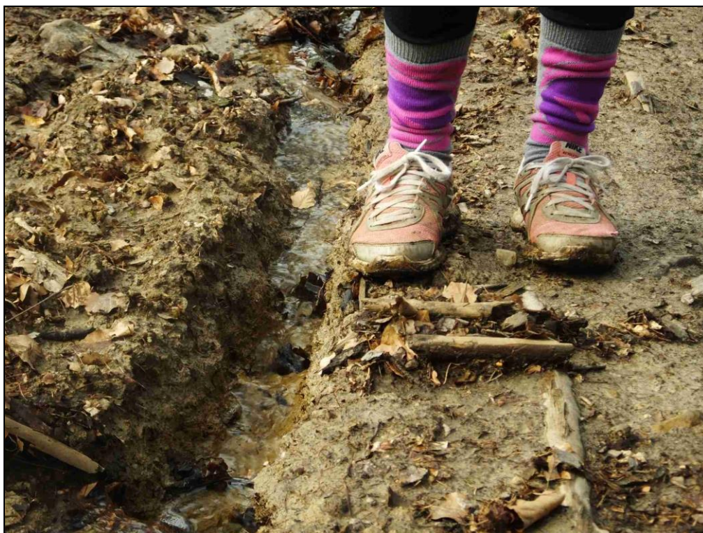
Obr. 17: Erozní rýhy na přístupové trase ke skalám na Budačině.
