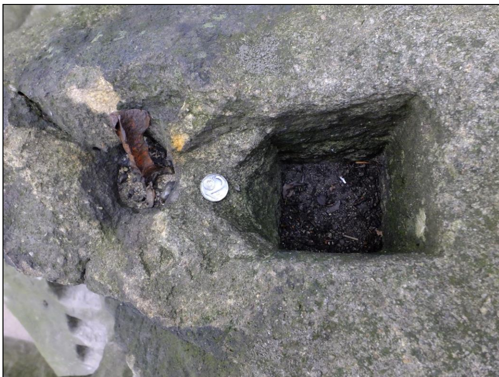
Obr. 25: Otvory po osazení zábradlí na Komínských skalách. (Vaculová 2015)
