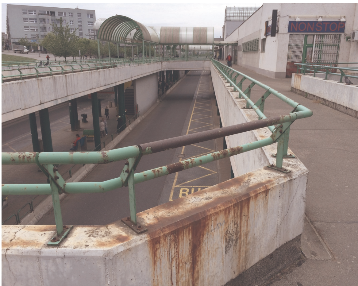
Obrázek 23: Stanice Černý most (Šafhauser, 2018)
