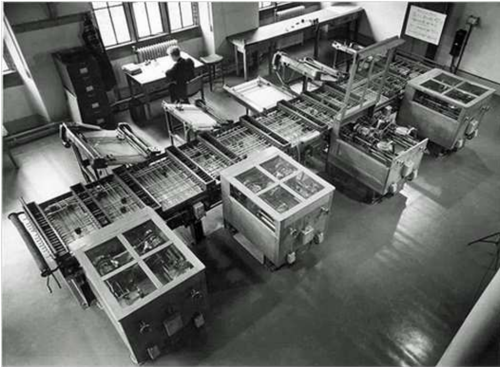
Obr. 69 Diferenciální analyzátor z roku 1938, který na základě Bushova návrhu postavily v laboratoři un. v Cambridge
