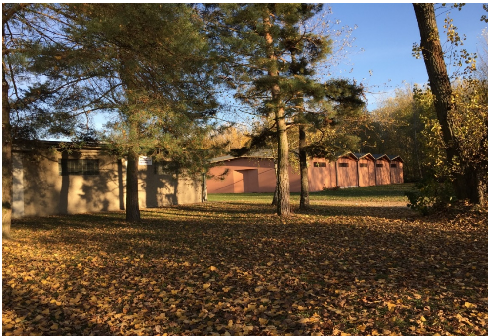
Obrázek 8. – Areál jachetního klubu (původní budova a přístavěná hala na úschovu lodí, PP Chomoutovské jezero (17.10.2015)
