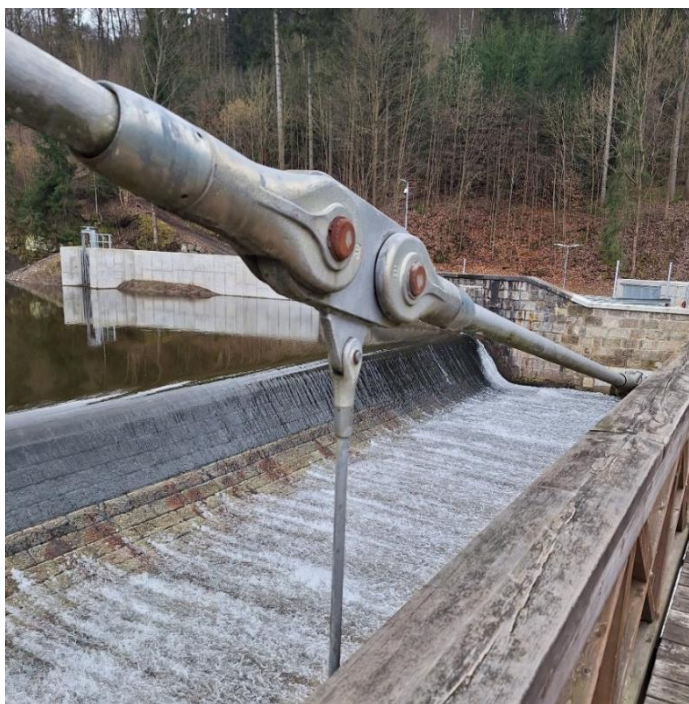
Obrázek 31-Připojení závěsů ve spoji táhel (autor)
