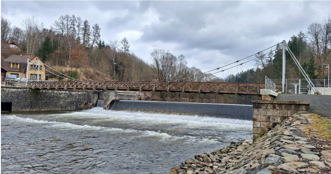
Obrázek 28-Celkový pohled na lávku z levého břehu (autor)
