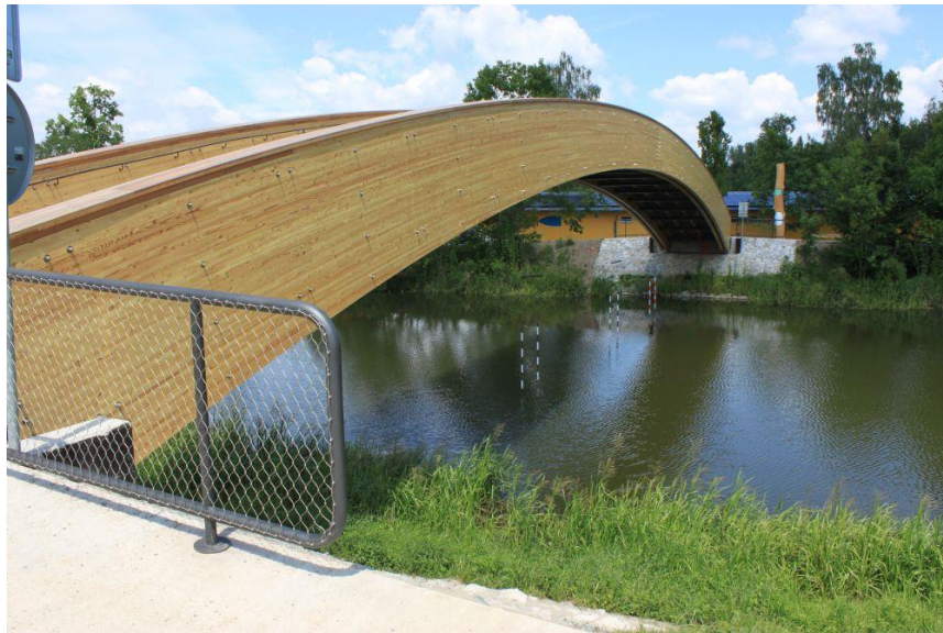
Obrázek 10-Lávka přes Chrudimku z lepeného lamelového dřeva (Lávka přes Chrudimku, 2017)
