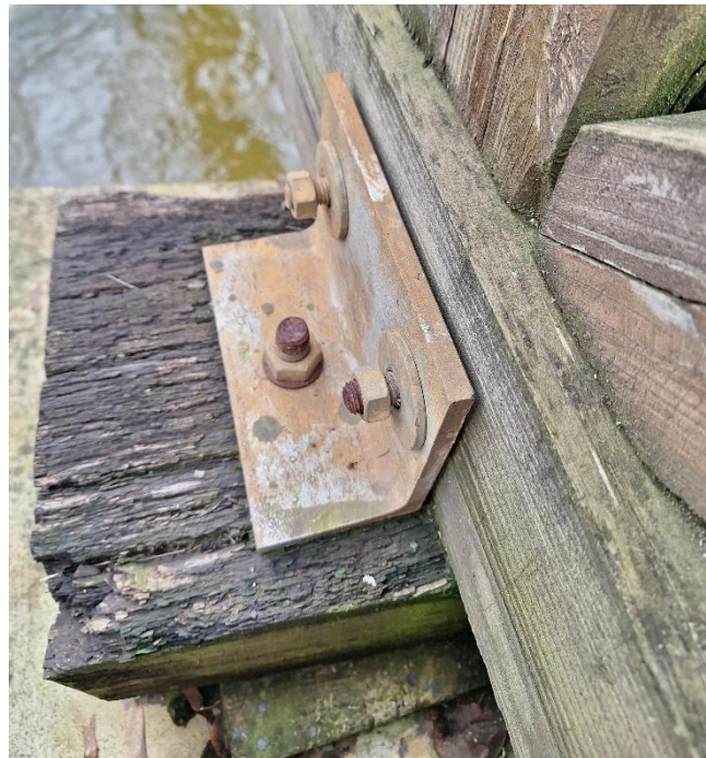
Obrázek 37-Povolené matice kování (autor)
