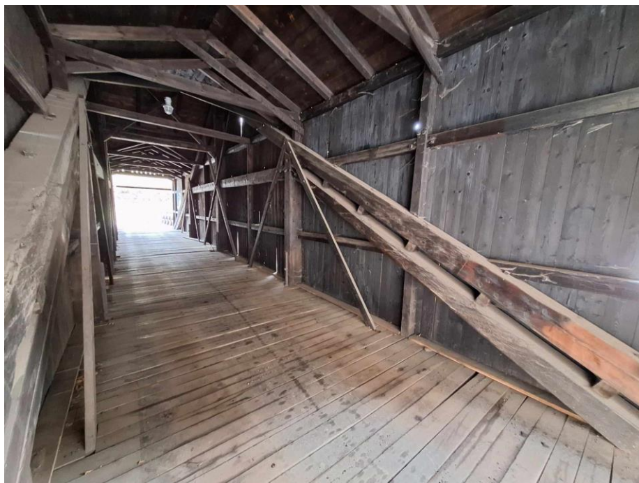
Obrázek 23-Pohled na konstrukci mostu (autor)
