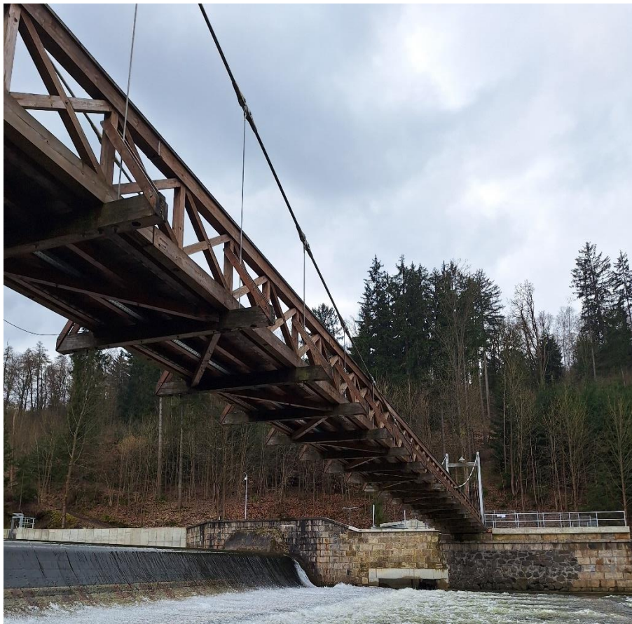
Obrázek 32-Dřevěná konstrukce lávky (autor)
