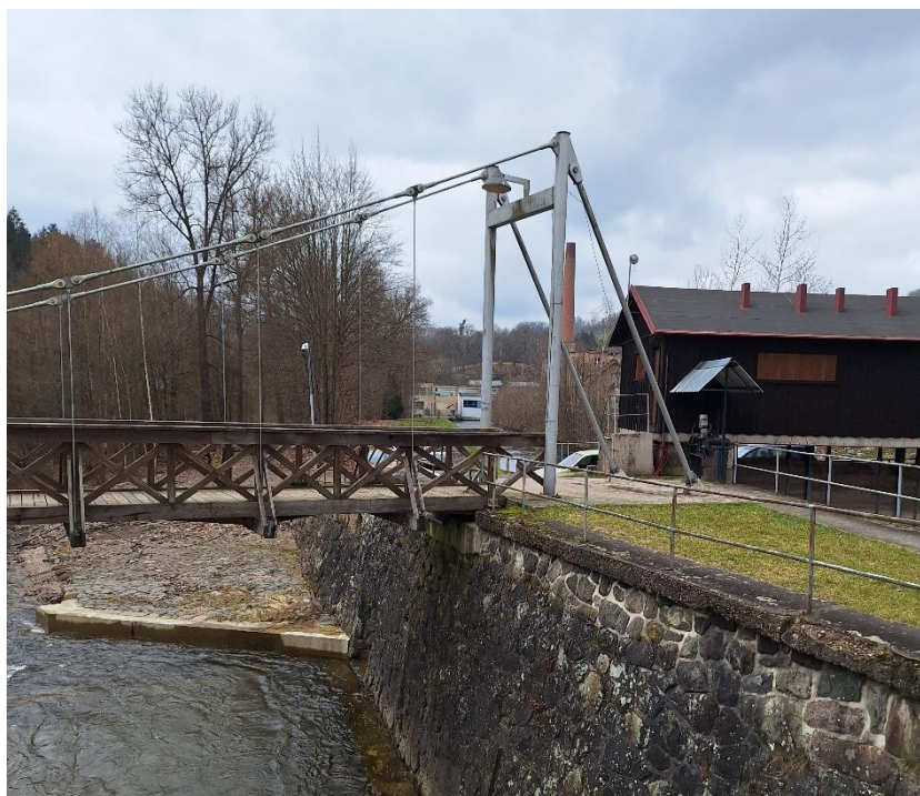
Obrázek 30-Založení mostu na pravém břehu (autor)
