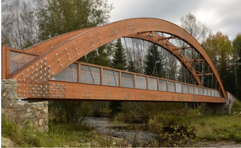
Obrázek 14-Obloukový most s dolní mostovkou přes Studenou Vltavu (Dřevěný most přes Studenou Vltavu, 2023)
