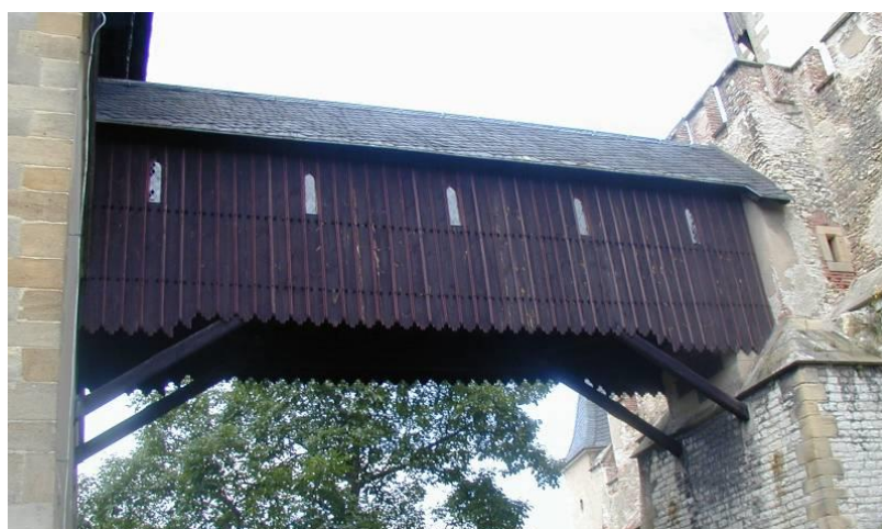
Obrázek 16-Vzpěradlový most na Karlštejně (Spojovací most mezi Mariánskou a Velkou věží, 2015)
