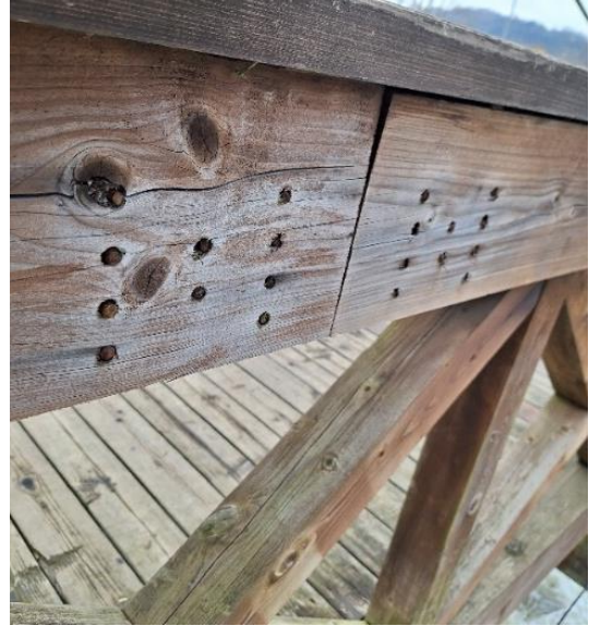
Obrázek 34-detail spojení nosníků z boku (vpravo) (autor)
