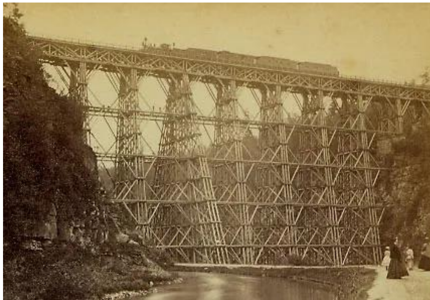
Obrázek 9-Železniční most Portageville (Portageville Railroad Bridge, 2018)
