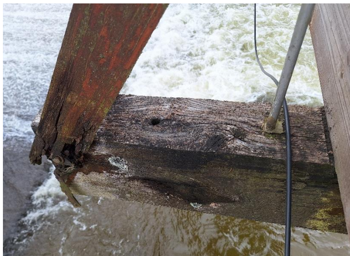
Obrázek 38-Hniloba vzpěry a spoj závěsu s příčnickem (autor)
