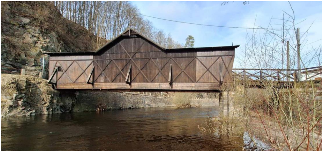
Obrázek 18- Celkový pohled na most proti proudu (autor)
