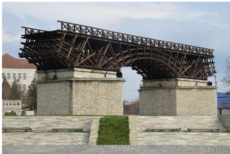
Obrázek 4-Rekonstrukce jednoho pole Trajánova mostu (Patowary, 2022)
