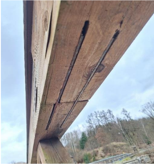
Obrázek 33-detail spojení nosníků zespodu (vlevo) (autor)
