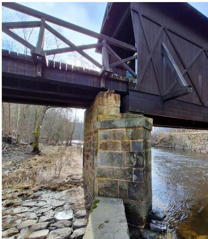
Obrázek 21-Pohled na pilíř a uložení obou polí (autor)
