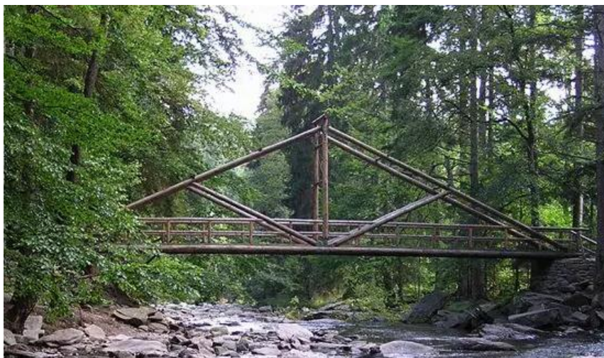
Obrázek 17-Původní Pašerácká lávka s jednoduchým věšadlem (Pašerácká lávka v Zemské bráně, 2022)
