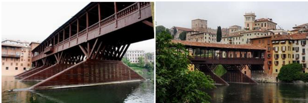
Obrázek 6-Most v italském Bassano del Grappa (Ponte degli Alpini, 2023)
