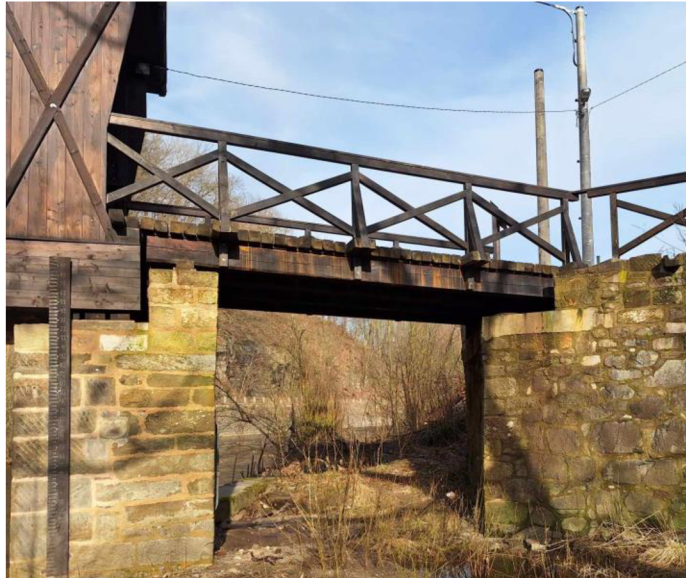
Obrázek 11- Trámové pole mostu Bystrá nad Jizerou (autor)
