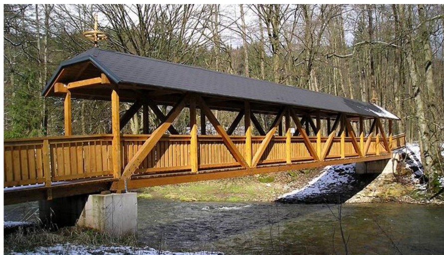
Obrázek 12-Dřevěná příhradová lávka přes Metuji v Pekle (Peklo, které si zamilujete, 2009)
