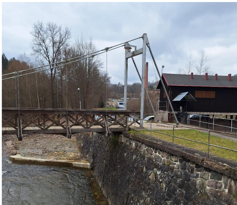
Obrázek 30-Založení mostu na pravém břehu (autor)
