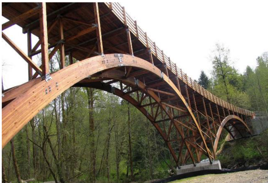
Obrázek 13-Obloukový most s horní mostovkou Jižní Dakota (KEYSTONE WYE BRIDGE, 2022)
