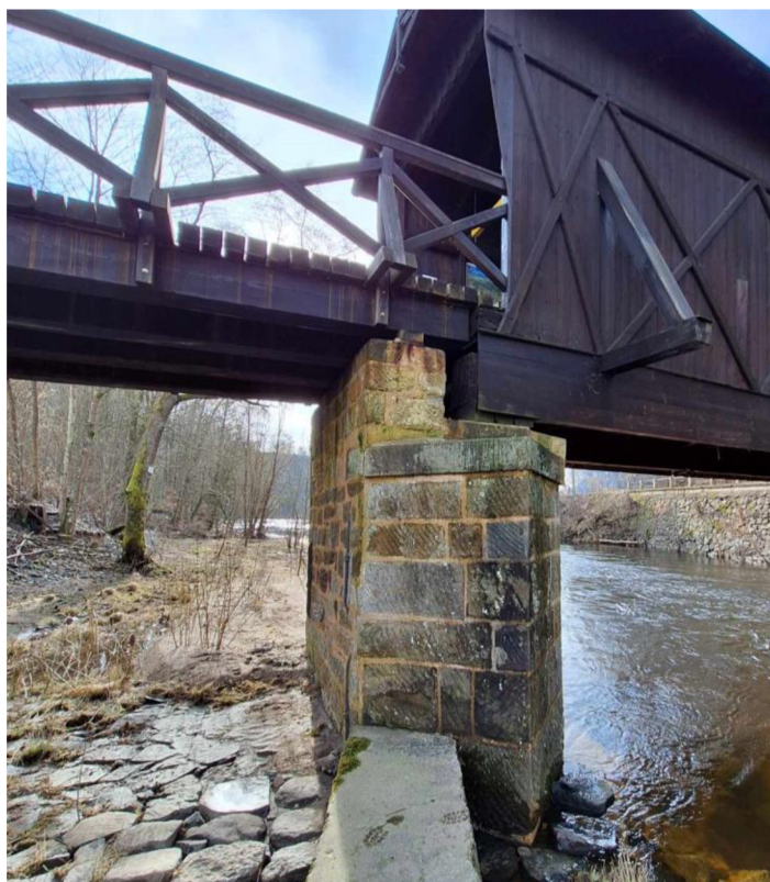
Obrázek 21-Pohled na pilíř a uložení obou polí (autor)
