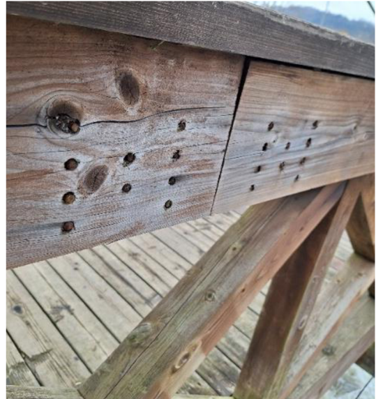
Obrázek 34-detail spojení nosníků z boku (vpravo) (autor)
