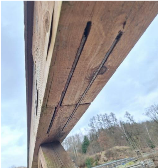
Obrázek 33-detail spojení nosníků zesponu (vlevo) (autor)
