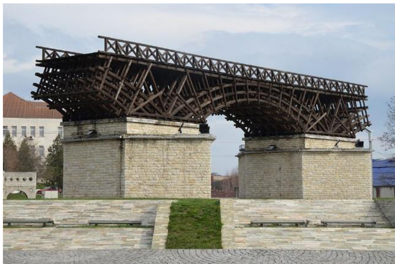
Obrázek 4-Rekonstrukce jednoho pole Trajánova mostu (Patowary, 2022)
