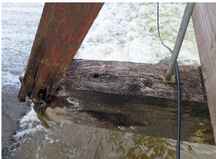
Obrázek 38-Hniloba vzpěry a spoj závěsu s příčnickem (autor)
