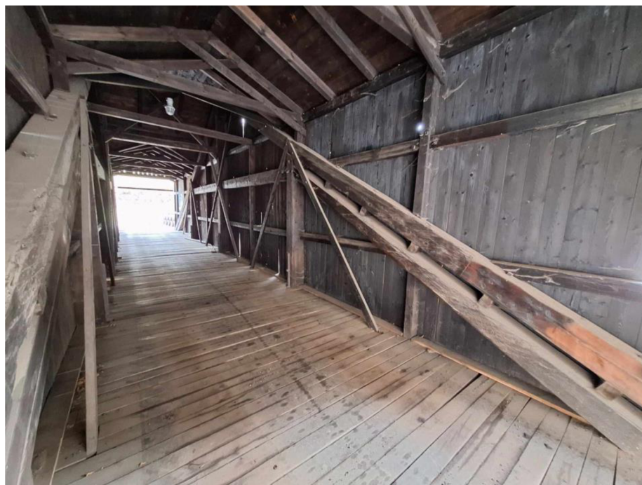
Obrázek 23-Pohled na konstrukci mostu (autor)
