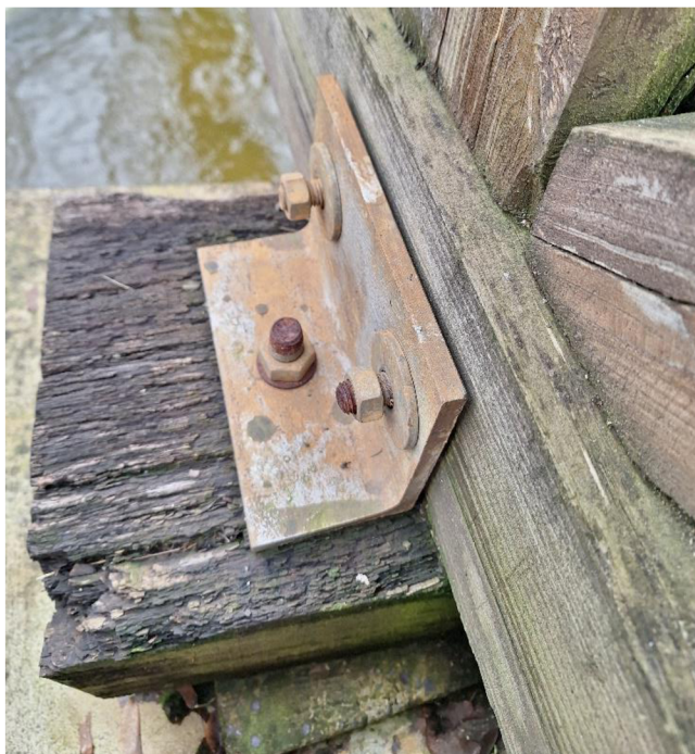
Obrázek 37-Povolené matice kování (autor)
