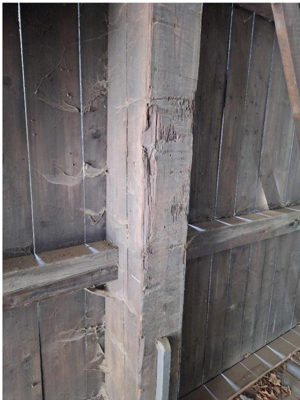
Obrázek 26-Poškození závěsu věšadla (autor)
