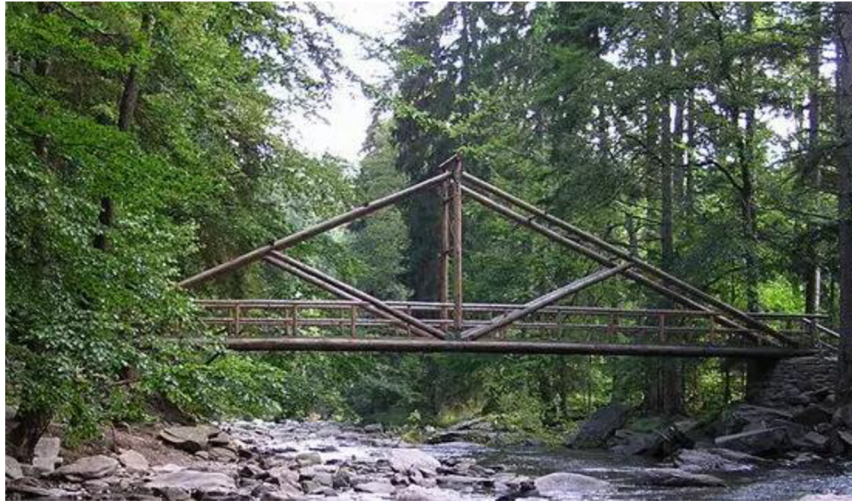
Obrázek 17-Původní Pašerácká lávka s jednoduchým věšadlem (Pašerácká lávka v Zemské bráně, 2022)
