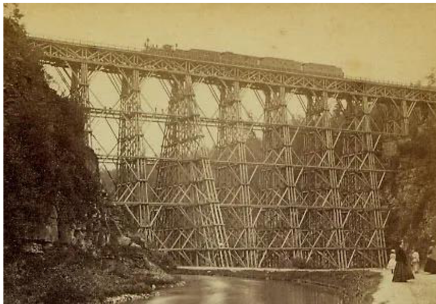
Obrázek 9-Železniční most Portageville (Portageville Railroad Bridge, 2018)
