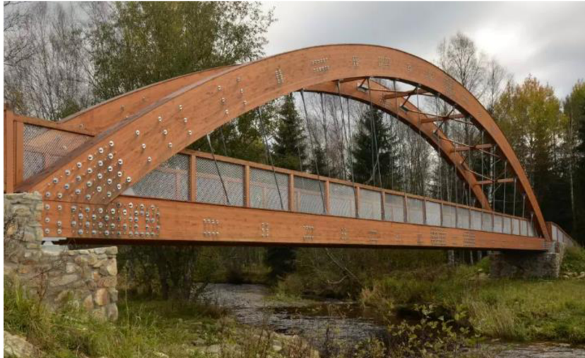
Obrázek 14-Obloukový most s dolní mostovkou přes Studenou Vltavu (Dřevěný most přes Studenou Vltavu, 2023)
