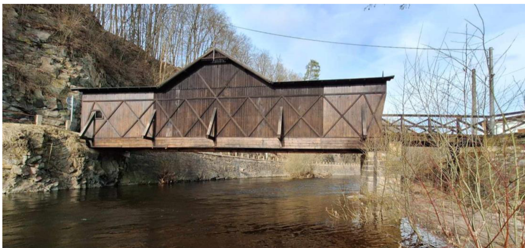
Obrázek 18- Celkový pohled na most proti proudu (autor)
