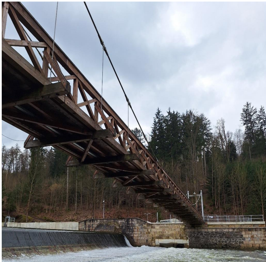
Obrázek 32-Dřevěná konstrukce lávky (autor)
