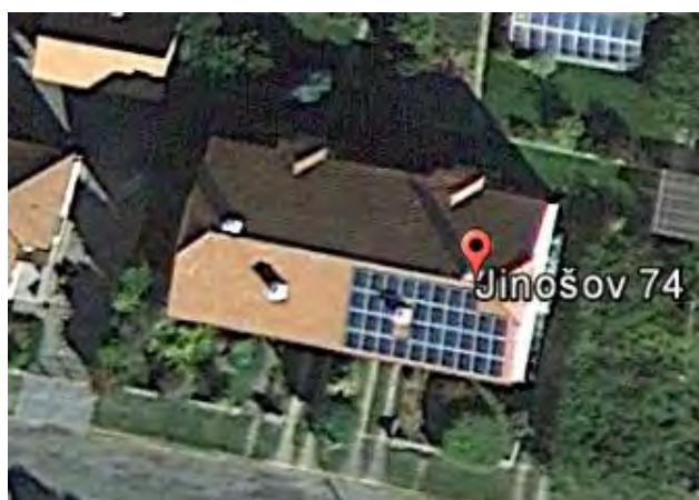
Obrázek 8.7 střecha RD s nainstalovanými FV panely (8).
