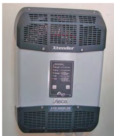
Obrázek 7.4 Střídač XTM 4000-48. (9)
