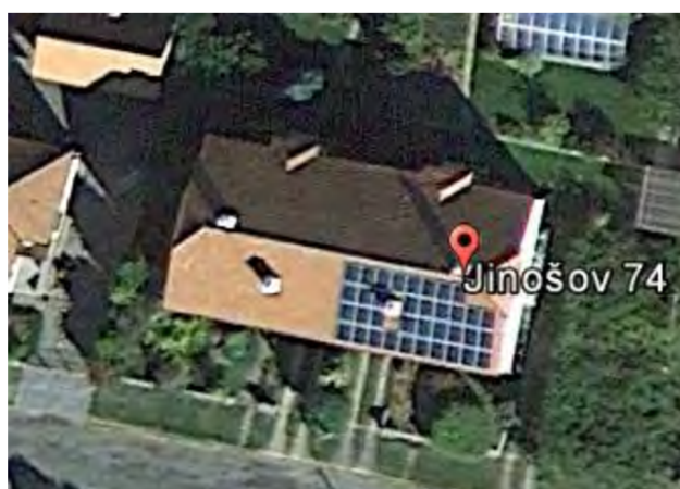
Obrázek 8.7 střecha RD s nainstalovanými FV panely (8).
