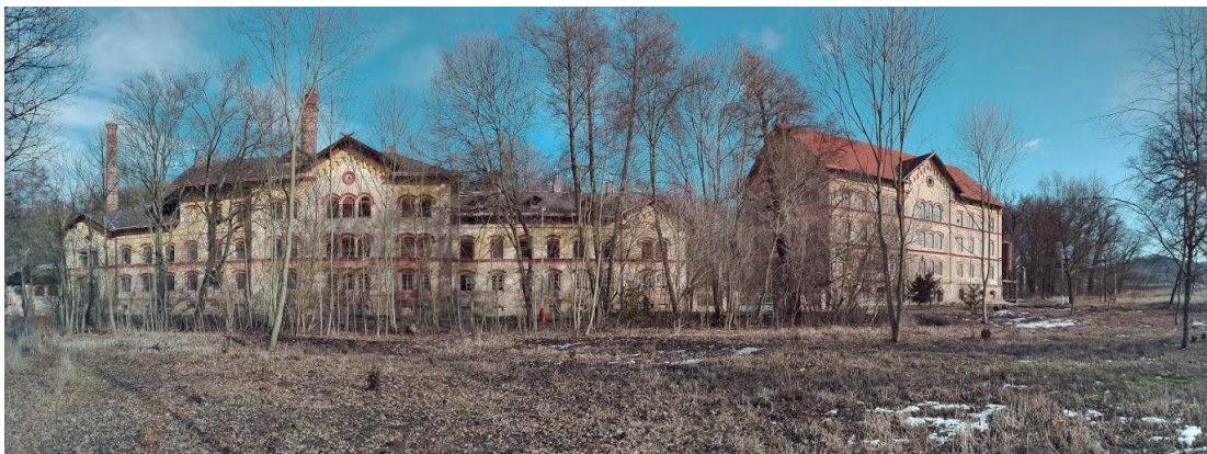
Panoramatický pohled na budovu bývalého pivovaru a přilehlou sýpku (Autor, 17. 2. 2017).
