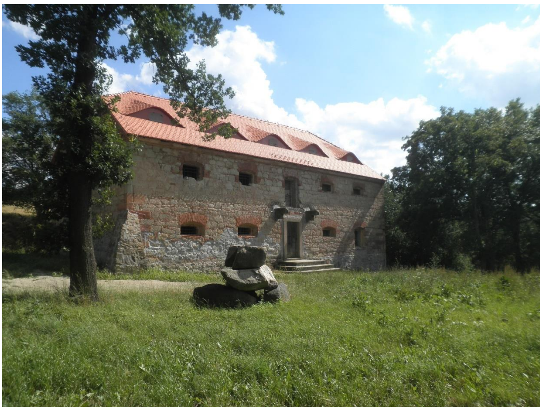
Budova sýpky u pole „Na Brandýse“ s již opravenou střechou (Autor, 9. 7. 2016).
