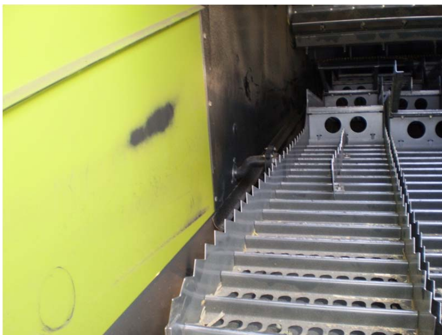
Obrázek 35 Místo po demontovaném vytřásadle
