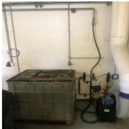
Obrázek 12 - Dávkování externího substrátu (vlastní zdroj)
