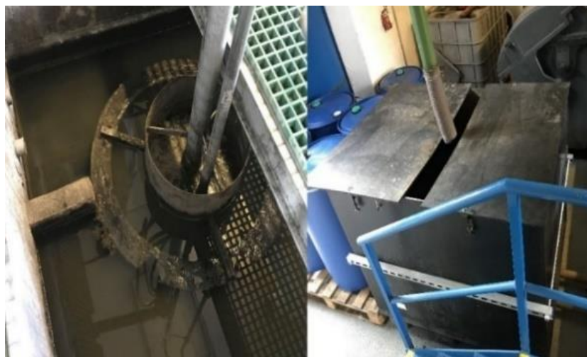
Obrázek 6 - Vertikální lapák písku s kontejnerem (vlastní zdroj)
