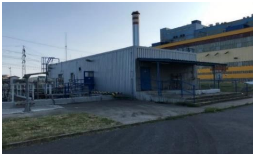
Obrázek 2 - Celkový pohled na BČOV (vlastní zdroj)
