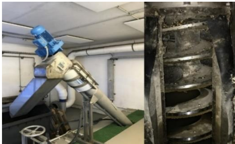
Obrázek 4 - Rotační šnek s detailem stíracích kartáčů na shrabky (vlastní zdroj)
