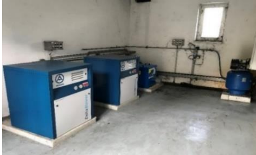
Obrázek 10 - Dmyhadle s kompresorem (vlastní zdroj)
