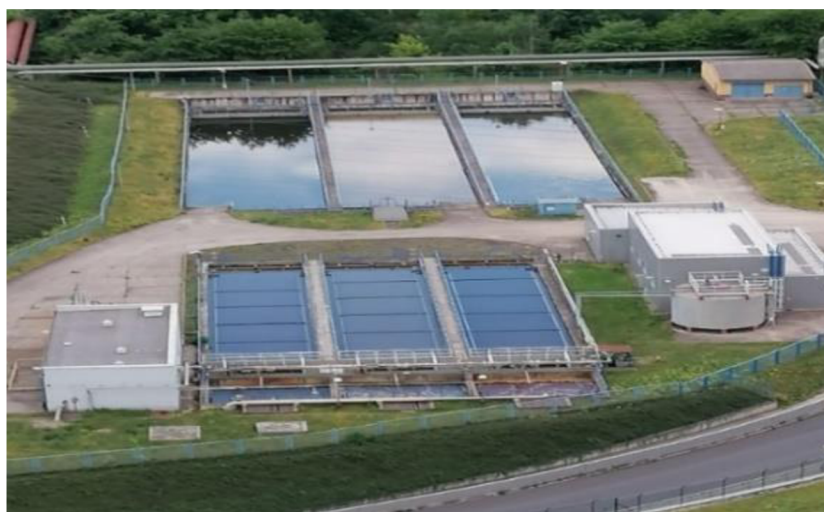
Obrázek 9 - Čistírna likvidace odpadních vod (vlastní zdroj)
