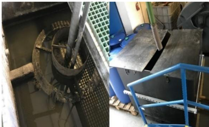
Obrázek 6 - Vertikální lapák písku s kontejnerem (vlastní zdroj)
