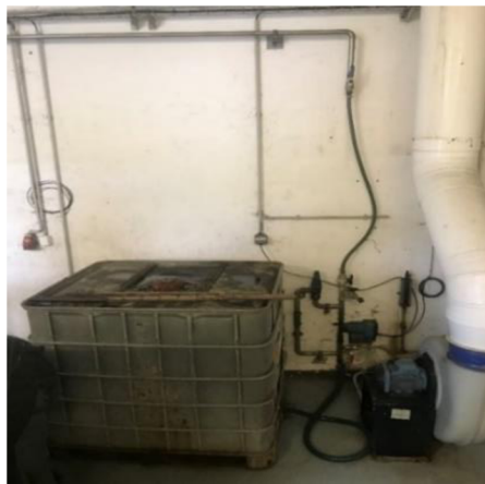
Obrázek 12 - Dávkování externího substrátu (vlastní zdroj)
