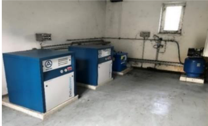
Obrázek 10 - Dmyhadle s kompresorem (vlastní zdroj)
