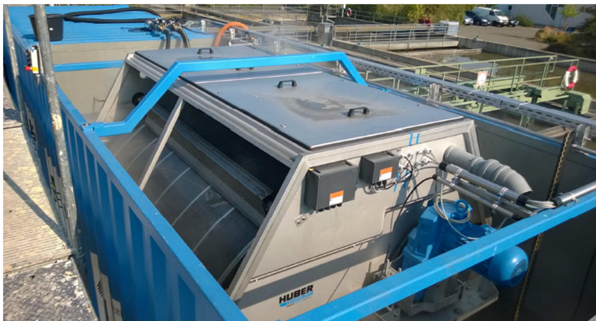
Obrázek 7.17 Výstupní část Drum Screen LIQUID Mesh, měření č. 2, Německo [22]
