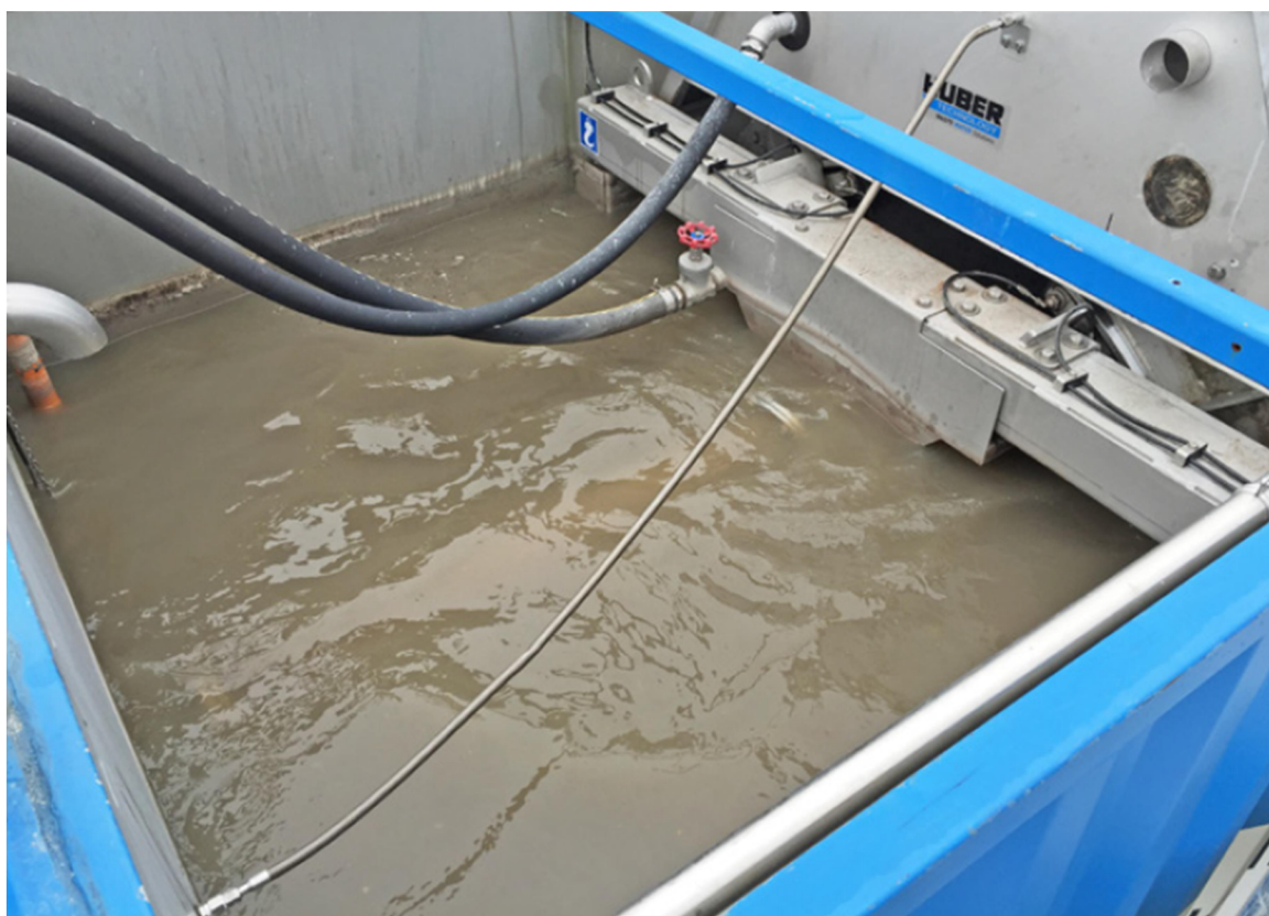
Obrázek 7.6 Maximální hladina před HUBER Drum Screen LIQUID [21]
