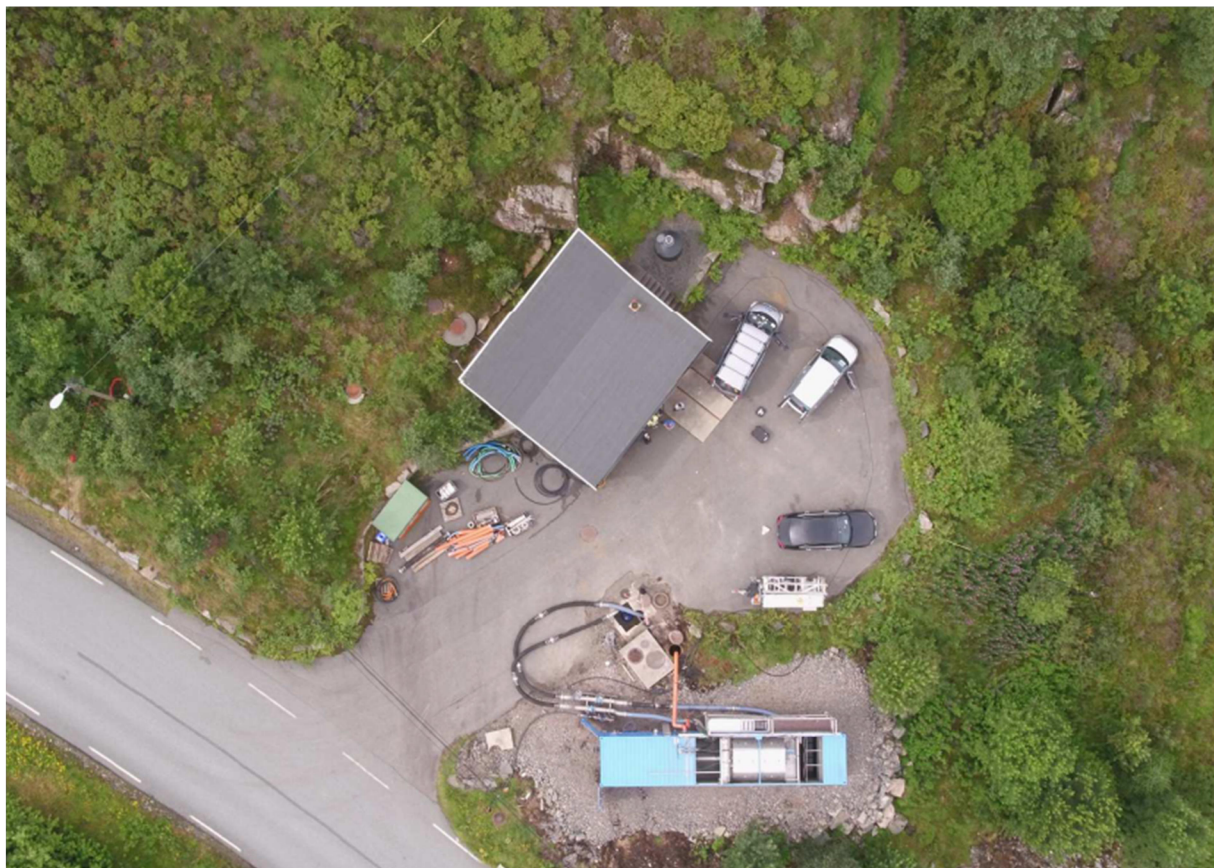
Obrázek 7.9 HUBER Drum Screen LIQUID celkový pohled shora, měření č. 1, Německo [22]
