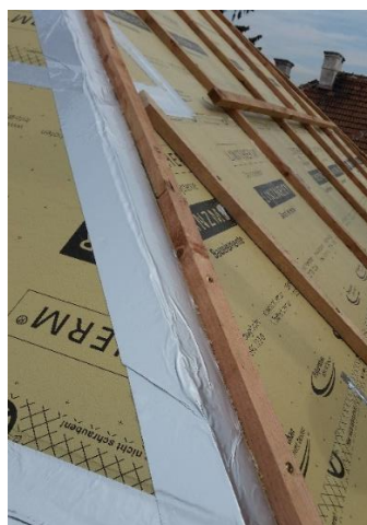
Obrázek 8 - Detail nadkrokevní izolace na nároží, zdroj: autor
