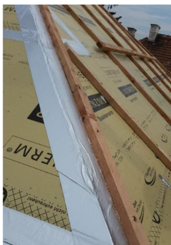
Obrázek 8 - Detail nadkrokevní izolace na nároží, zdroj: autor
