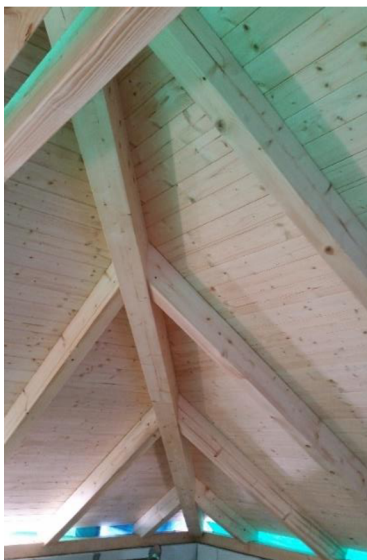
Obrázek 7 - Detail nároží, zdroj: autor
