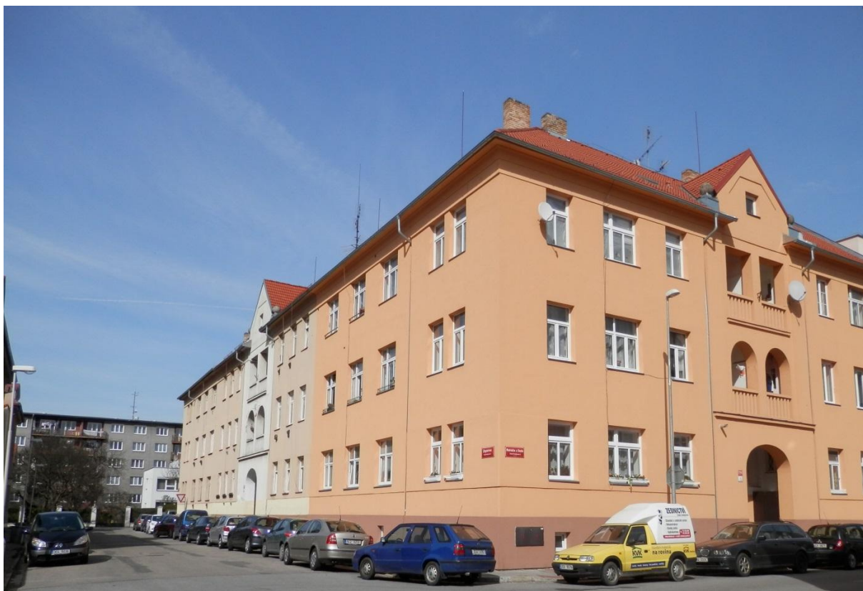
Foto 6: Plocha č. 7 – ulice Čechova. Nedávno revitalizovaný vícebytový dům v jedné z bočních ulic. Zde více klidu než podél Čechovy ulice (foto Simona Šturmová, 2017).
