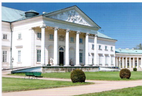
Významný empírový zámek Kačina nedaleko Kutné Hory nechal postavit Jan Rudolf Chotek podle plánů drážďanského architekta Christiana Friedricha Schurichta. Nyní je v něm Muzeum českého venkova.
