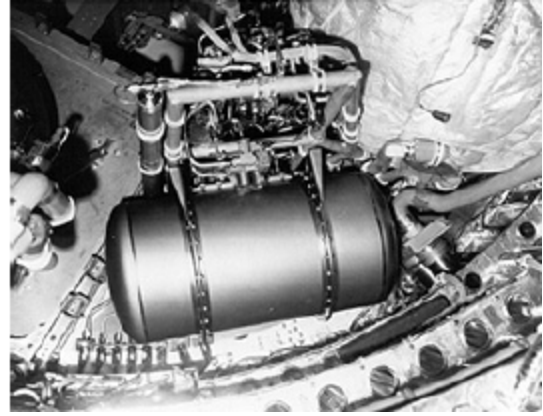
Obr. 2.5: Palivový článek (PEM) pro vesmírný program Gemini (1963) [5]
