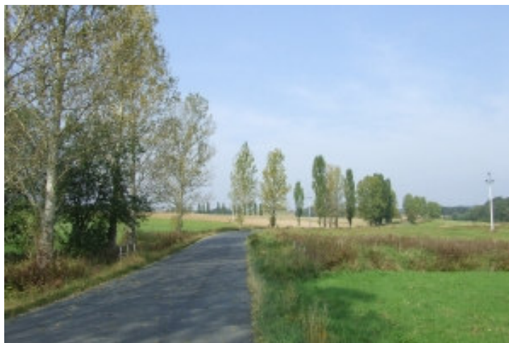
Obr. č. 1: Pohled na silnici III/18310 směrem na Blížejov (Boučková 2009)
