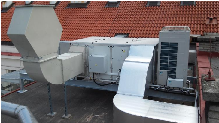
Obr. 10 VZT jednotka s okruhem TČ [16]
