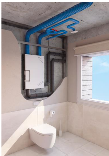
Obr. 14 Umístění VZT jednotky Avent G [19]
