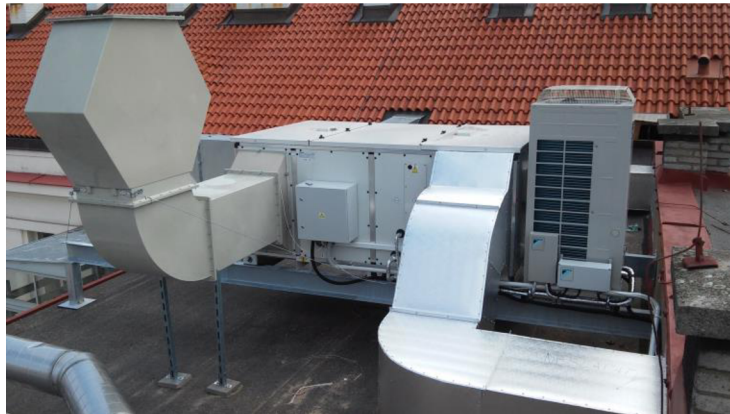
Obr. 10 VZT jednotka s okruhem TČ [16]
