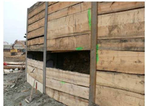
Obr. 9.2. Záporové pažení (převzato z [29]).
