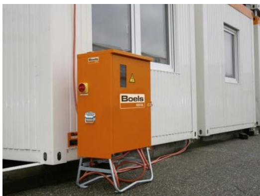
Obr. 4.12. Rozvaděč pro staveniště (převzato z [14]).
