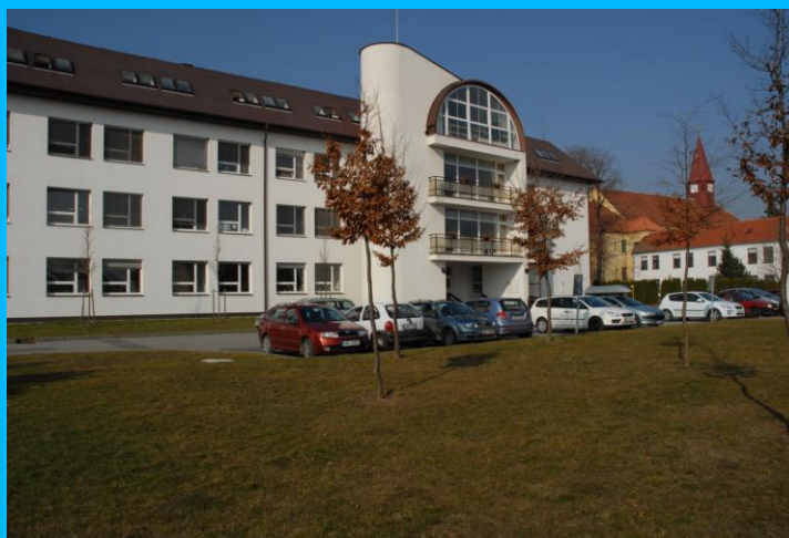
Obr. 19: Dům léčby bolesti s hospicem sv. Josefa v Rajhradě, v pozadí klášter sester Těšitelek Božského Srdce Ježíšova 215
