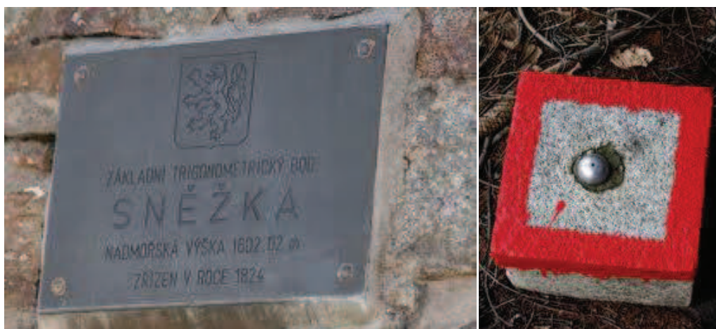
Obr. č. 8: Ukázka označení trigonometrických bodů v terénu. ( http://www.tisicovsky.cz )
