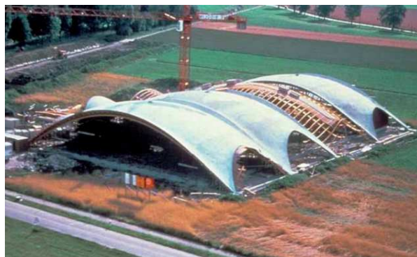
Obr. 2-6 Tenisová hala v Düdingenu – postupná výstavba [4]
