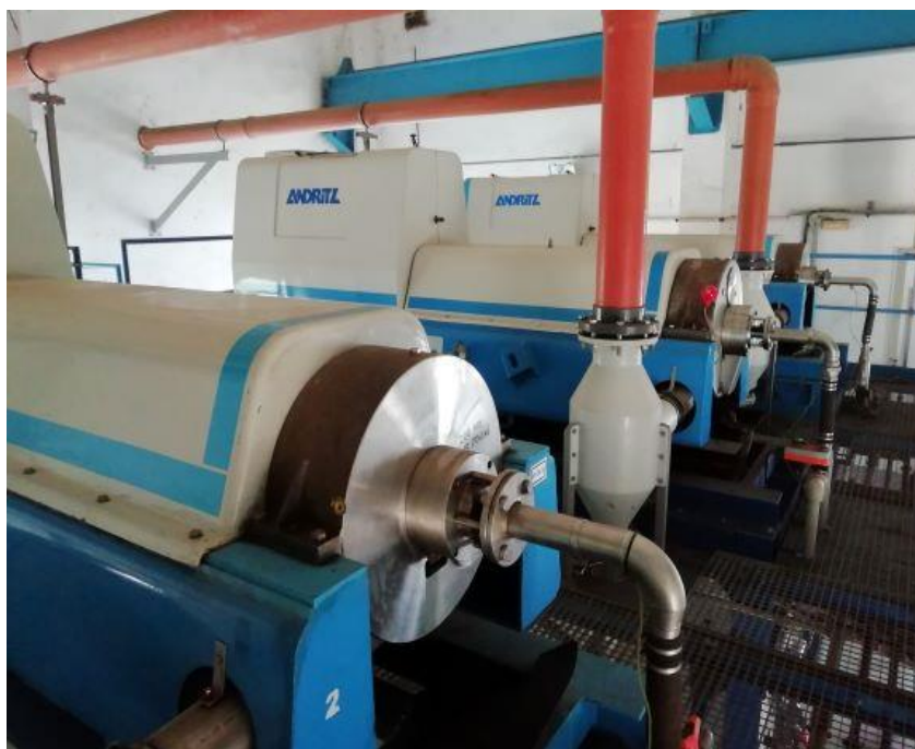
Obr. č. 16 – Odstředivky sušárna kalů ČOV – Drahotice (foto autor, 2019)
