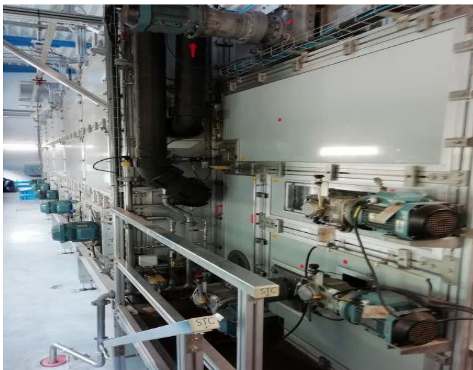
Obr. č. 5 - Nízkoteplotní sušárna kalů ČOV- Drahovice (foto autor, 2019)
