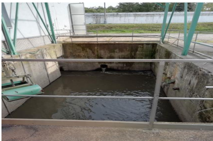
Obr. č. 8 - Lapák písku na ČOV - Drahovice (foto autor, 2019)
