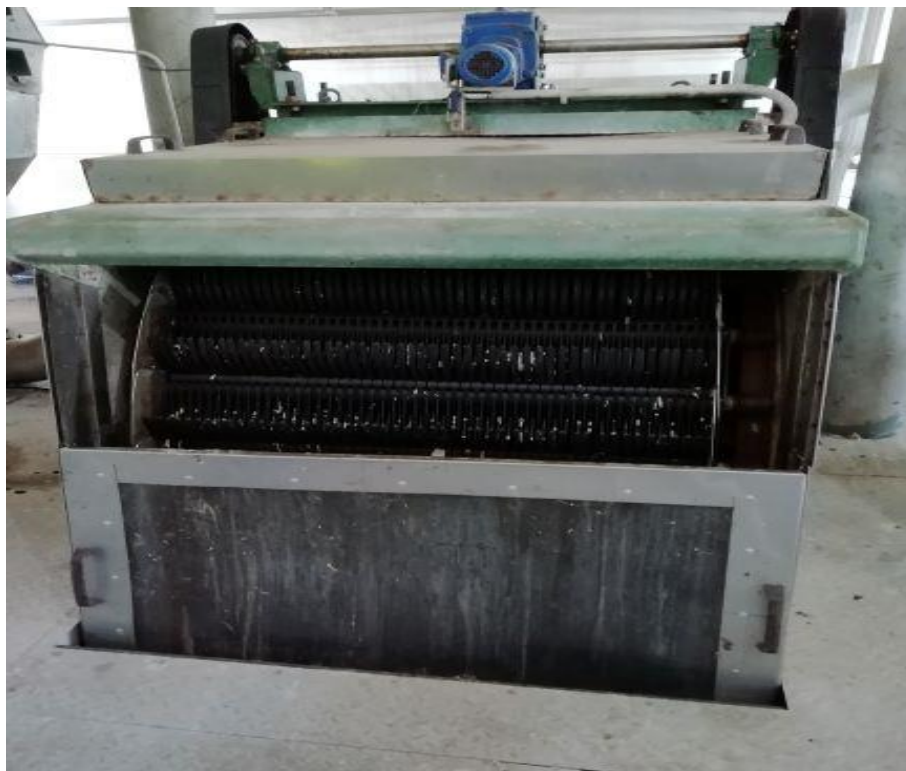
Obr. č. 7- Jemné česle ČOV - Drahovice (foto autor, 2019)
