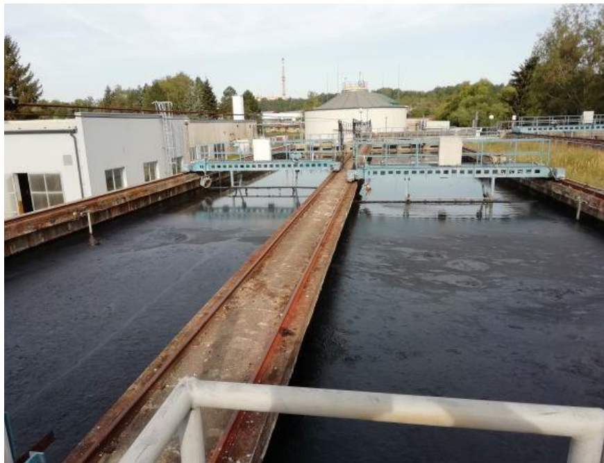
Obr. č. 9 - Usazovací nádrž ČOV- Drahovice (foto autor, 2019)
