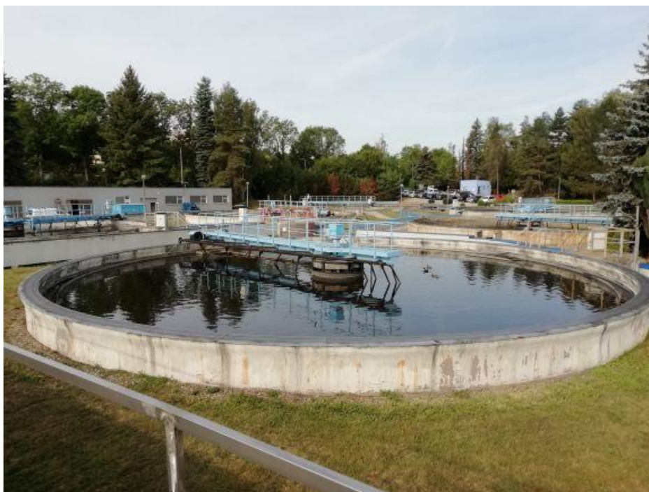
Obr. č. 13- Dosazovací nádrže ČOV – Drahovice (foto autor, 2019)
