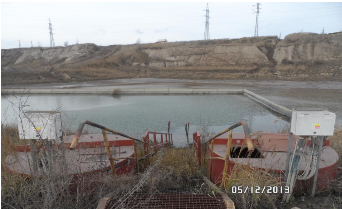
foto č. 12, Retenční nádrž 514 se dvěma studnami (foto: vlastní, 12/2013)
