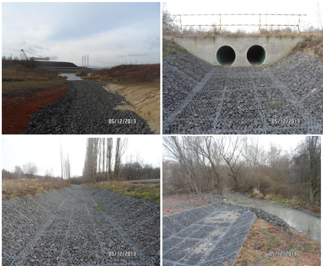
foto č. 14 – 17, Retence N1 + kamenné koryto s vyústěním (foto: vlastní, 12/2013)
