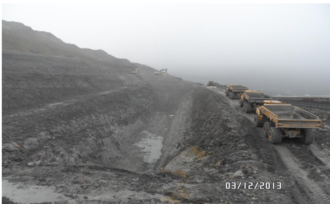
foto č. 19, Nově budovaná retence Jih3 (foto: vlastní 12/2013)
