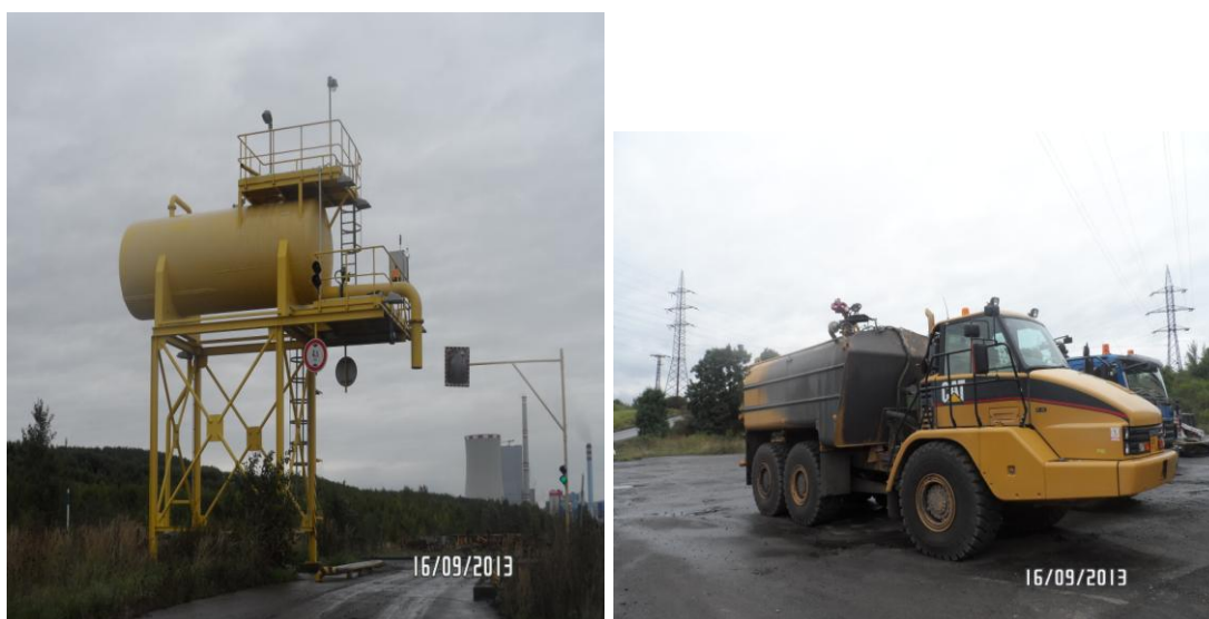
foto č. 36-37, Napouštěcí věž + skrápěcí vůz (foto: vlastní, 09/2013)
