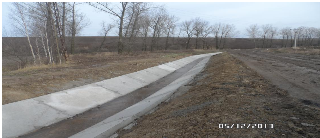
foto č. 7, Nově vybudovaný záchytný betonový příkop (foto: vlastní, 12/2013)
