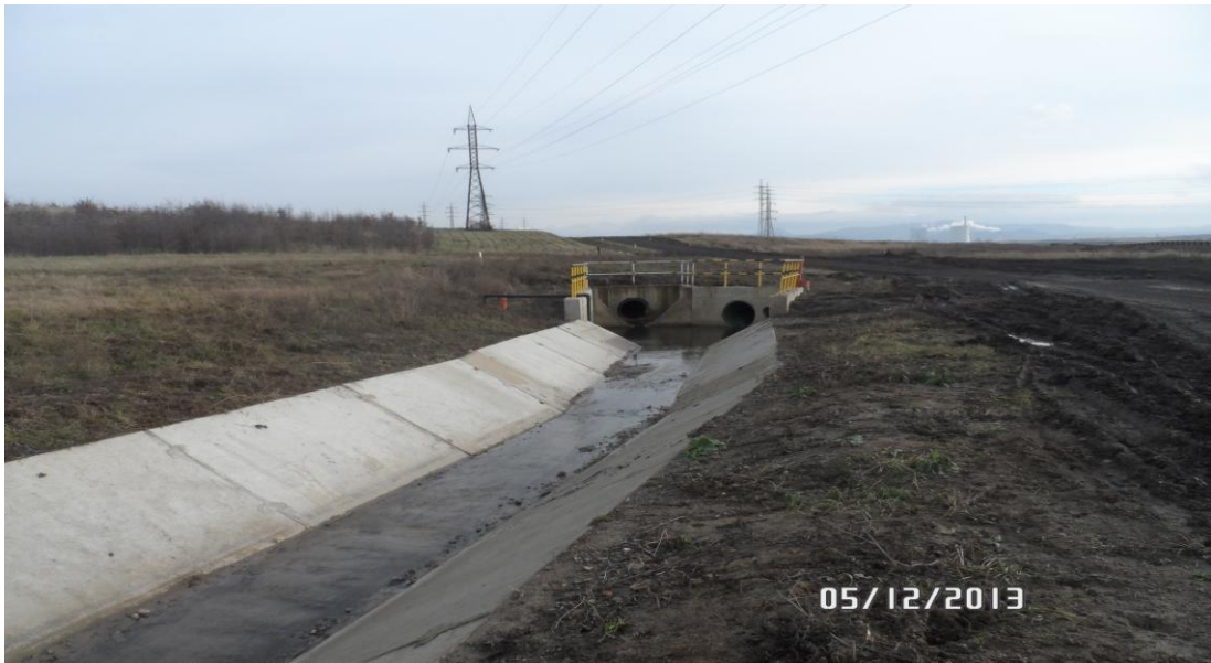
foto č. 8, Zaústění do navazujícího potrubí (foto: vlastní, 12/2013)
