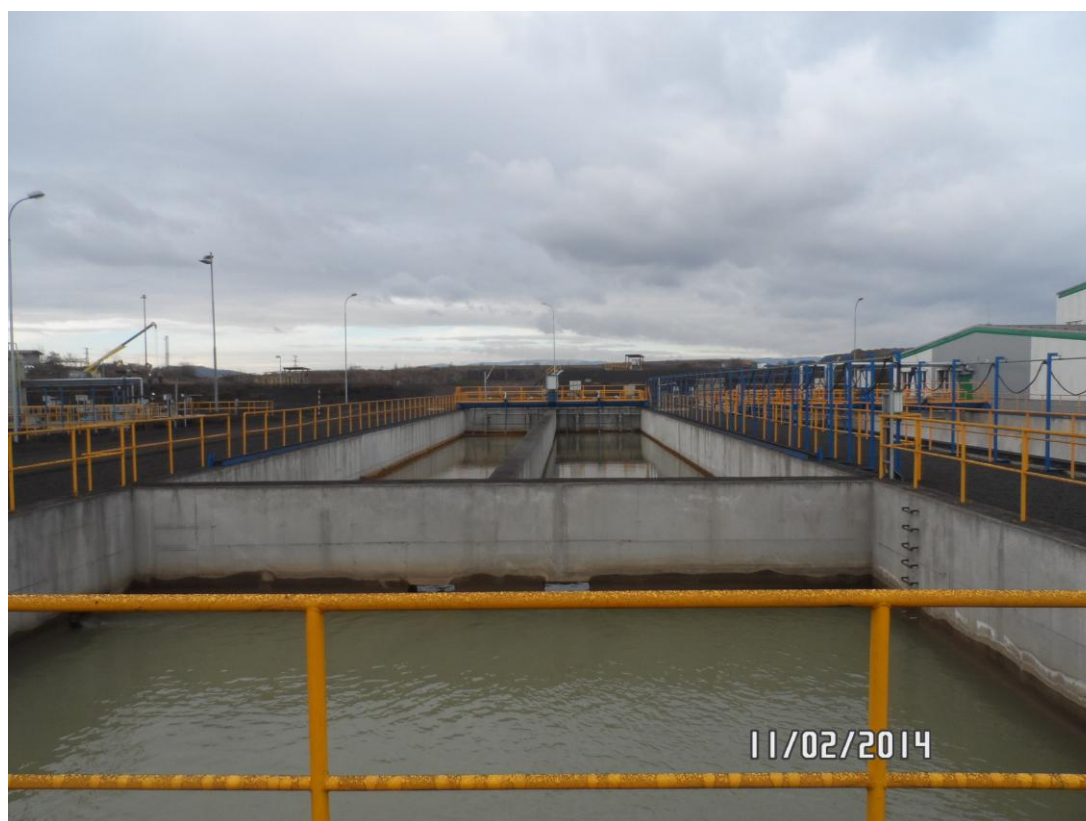
Příloha č. 6: Usazovací nádrže, v popředí s egalizační jímkou (foto: Vlastní, 02/2014).
