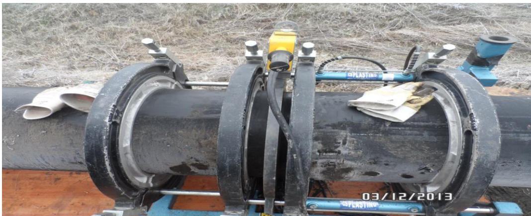
foto č. 25, Svařování na tupo za využití hydraulické svářečky (foto: vlastní, 12/2013)
