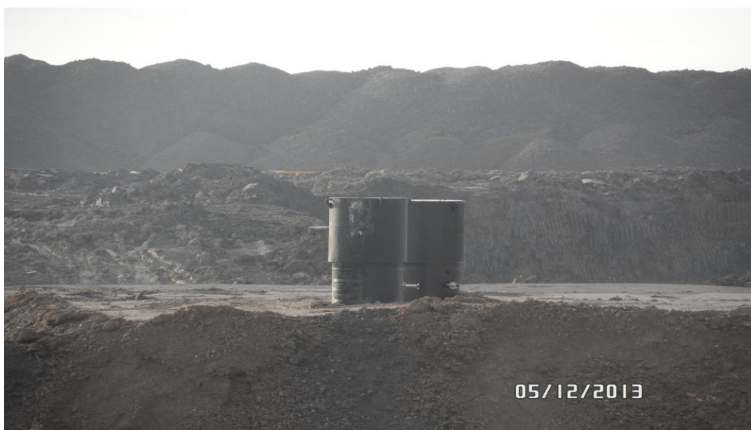
foto č. 13, Nové odvodňovací vrty u Ledvického koridoru (foto: vlastní, 12/2013)
