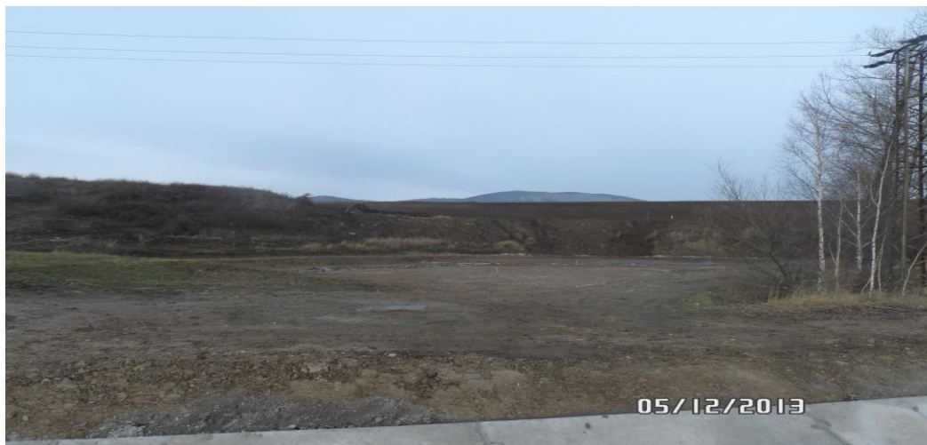
foto č. 6, Bývalá retenční nádrž I (foto: vlastní, 12/2013)
