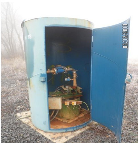
foto č. 27-28, Odvodňovací vrtné studny + vyústění do stávající vodoteče (foto: vlastní, 12/2013)
