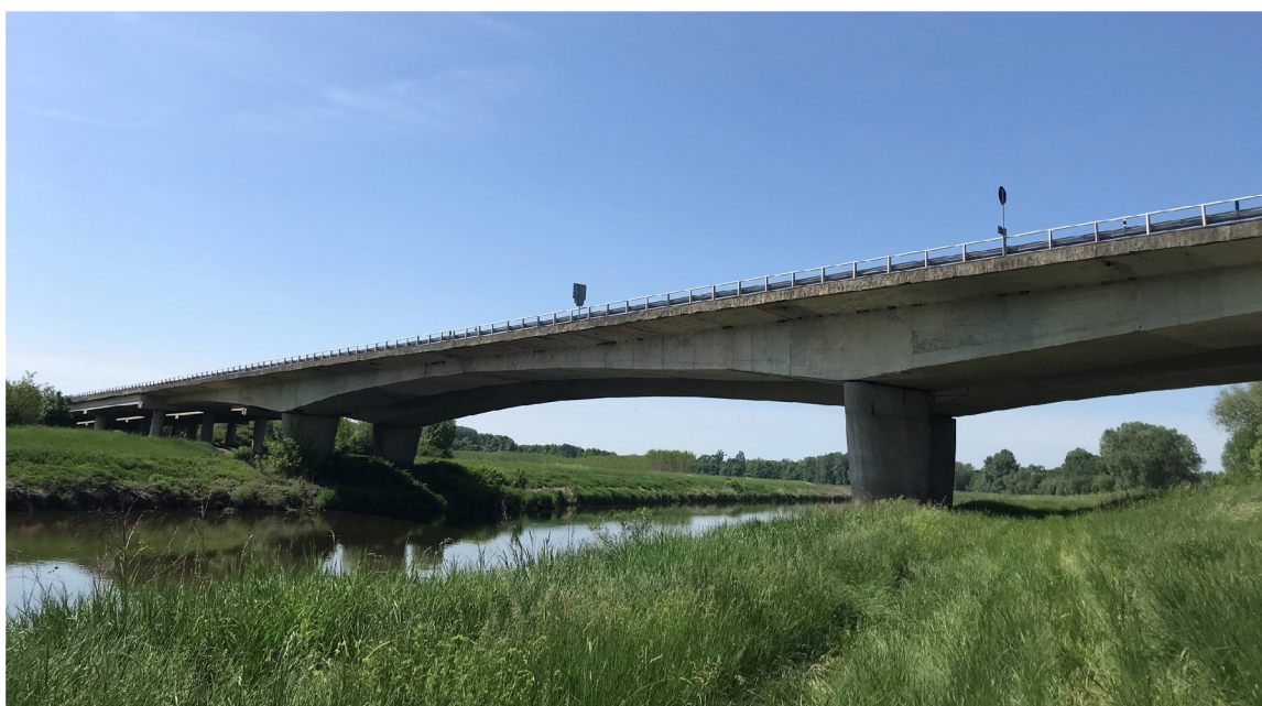
Obrázek 3.2: Pohled na levý most hlavního mostního objektu, hlavním nosným prvkem je komorový nosník proměnné výšky průřezu
