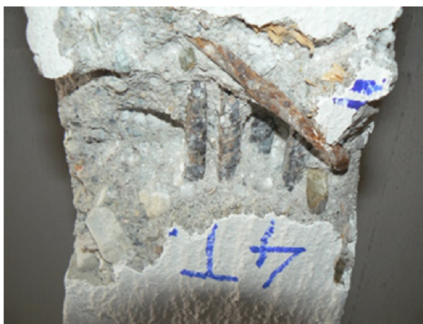
Obrázek 2.8: Rozsáhlá sekaná sonda na trámu [10]
