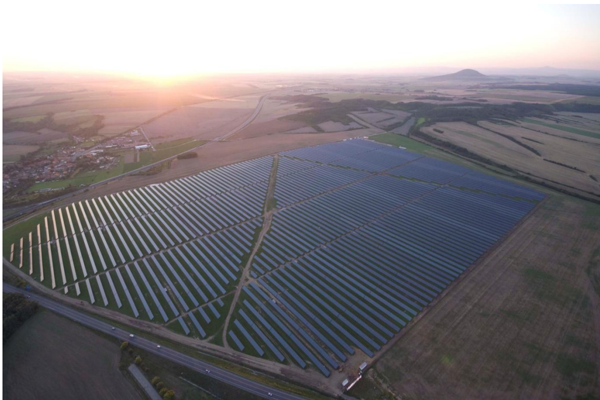
Obr. č. 73, Řipská krajina s fotovoltaičnou elektrárnou (firma Silekto, s.r.o.).
