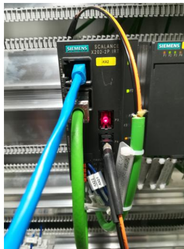
Obrázek 10: Připojení kabelu do sběrnice
