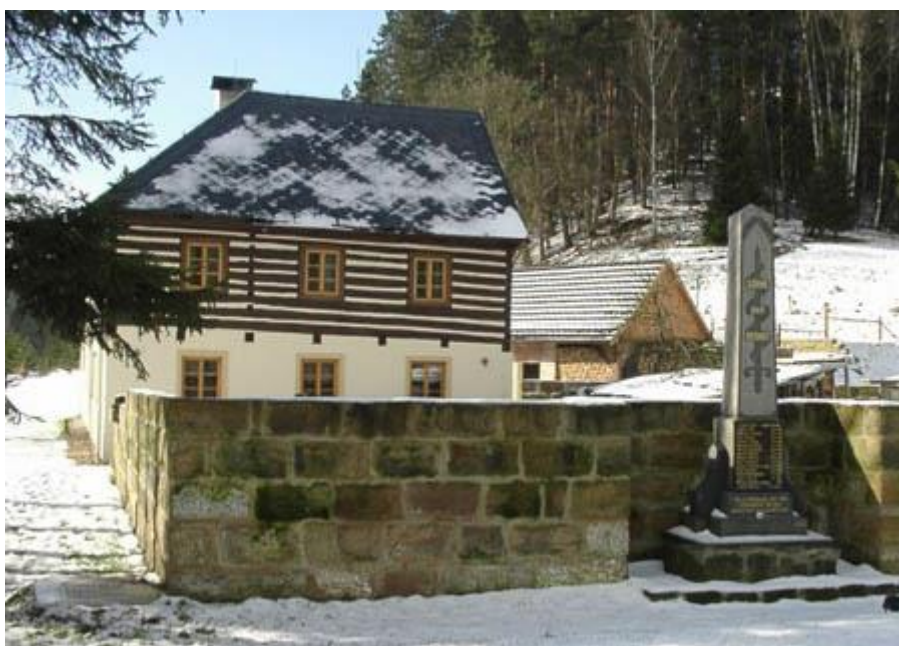
Příloha č. 13 - Penzion V Ráji, pohled v zimě ze silnice. Vpředu opravený pomník padlým. Zdroj autor.
