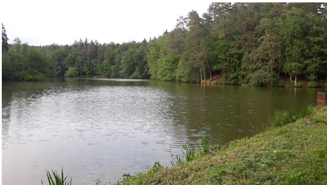
Obr. 5: Pohled na korunu hráze nádrže Švýcar
