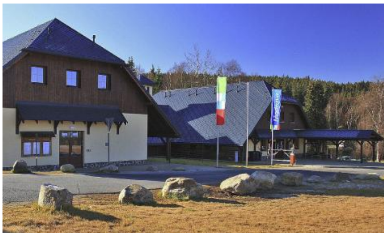
Obrázek 1 Budova obce Modrava
