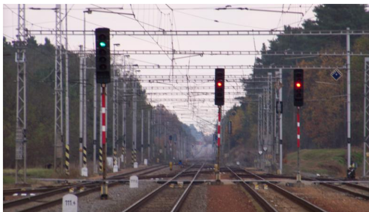
Obr. 8: Odjezdová návěstidla ve stanici Rohatec s návěští volno (vlevo) a s návěští stůj (vpravo).
