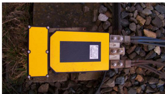
Obr. 1: Vyhodnocovací zařízení kolejového obvodu.
