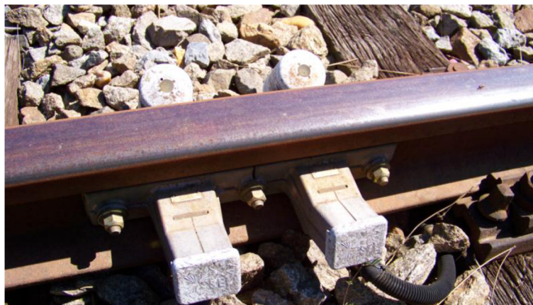
Obr. 5: Senzor počítače náprav.
