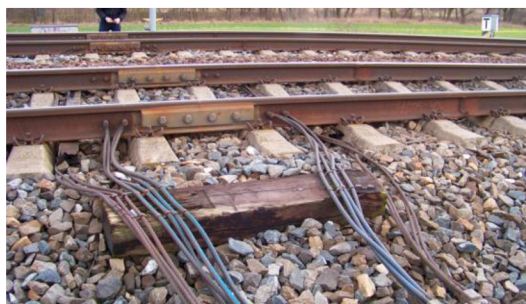
Obr. 2: Napojení kolejového obvodu.
