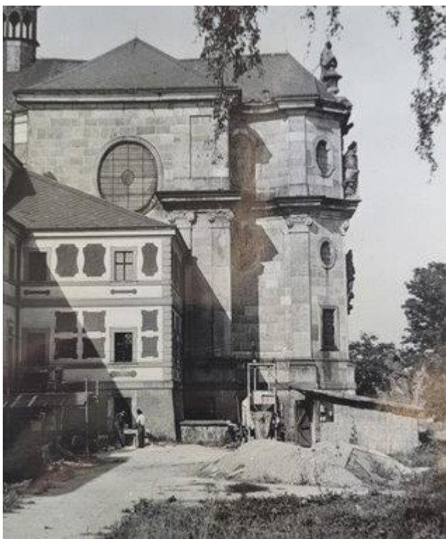
Obrázek 4: Záběr na dočasnou kůlnu místo zvonice – NPÚ, Projektový úkol na rekonstrukci hospitálu, III. svazek
