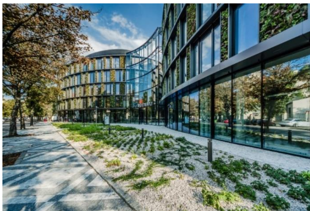
Obr. 2-10: Kaskádová zahrada - Administrativní budova AFI Karlín Butterfly v Praze, 2018 [10]
