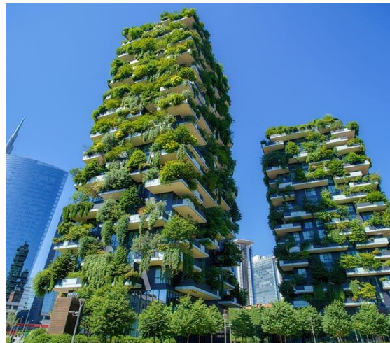
Obr. 2-5: Dvě věže Vertical Forest v Miláně (2009-2014) [7]
