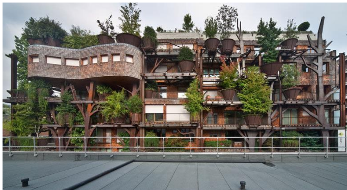
Obr. 2-4: Bytový dům v Turíně, Itálie (2014)
