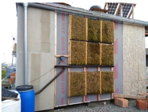
Obr. 4-4: Mechové panely instalované na testovacím objektu v Centru AdMaS, 09/2017
