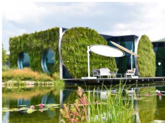
Obr. 2-12: Kancelářská budova Liko-Noe, f. Liko-S, Slavkov u Brna, 2015 [12]
