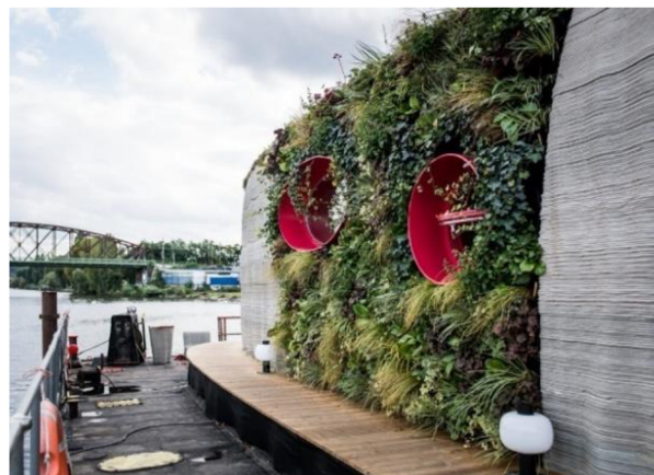
Obr. 2-11: : Intenzivní zelená fasáda prvního 3D tištěného domu Prvok v České republice, Praha 2020 [11]
