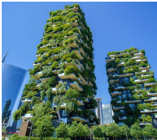
Obr. 2-5: Dvě věže Vertical Forest v Miláně (2009-2014) [7]
