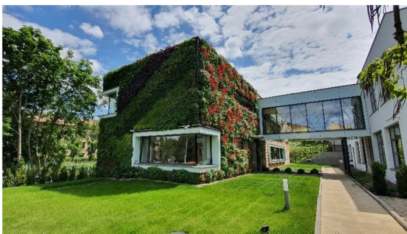
Obr. 2-15: Severozápadní pohled na zelenou fasádu přístavby KVOP
