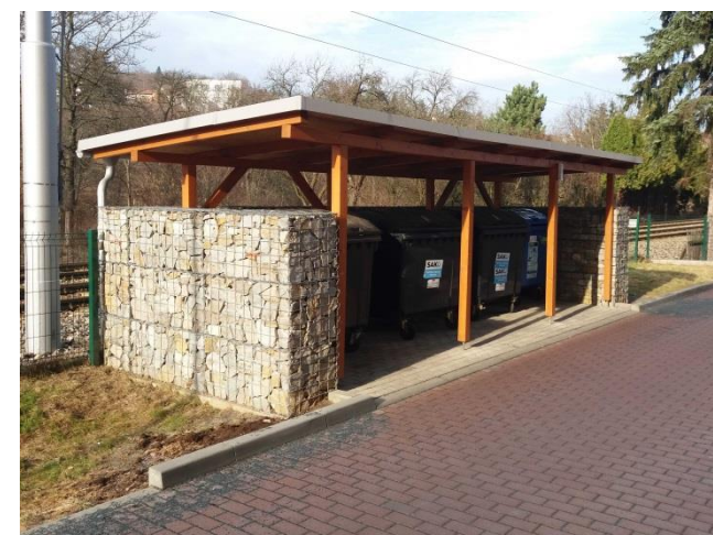
Obr. 44 – Přístřešek pro kontejnery
