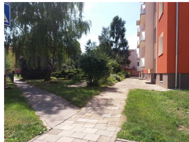
Obr. 68 – Nejednotnost zpevněných povrchů
