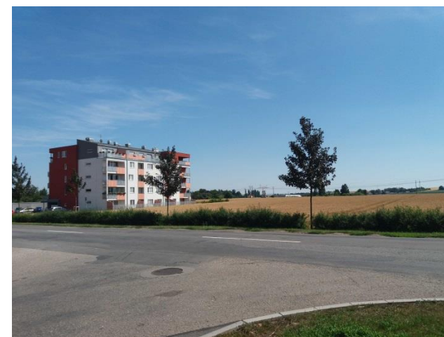
Obr. 89 – Prach a zápach z pole
