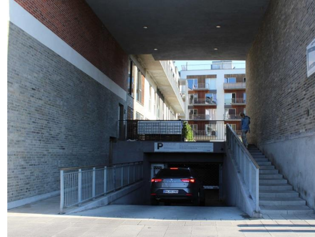
Obr. 27 – Podzemní garáže – Kodaň – Sydhavnen
