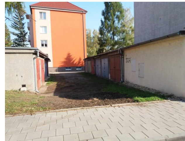
Obr. 85 – Esteticky nevzhledná budova – garáže
