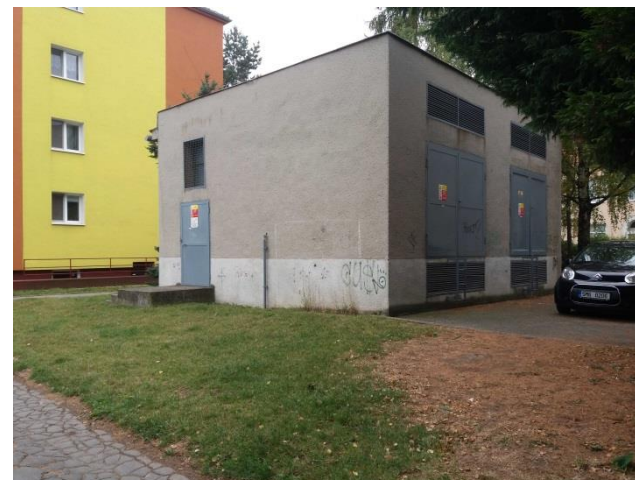
Obr. 84 – Esteticky nevzhledná budova – trafostanice
